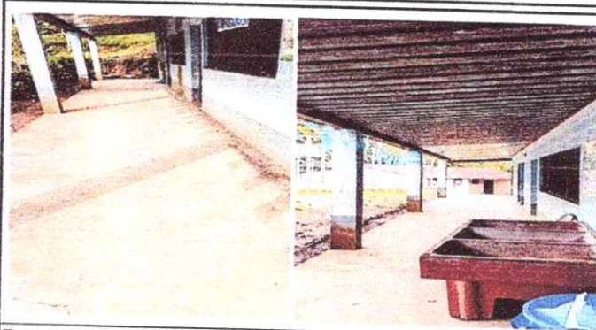
Foto 14: PINTURA EN MUROS EXTERIORES E INTERIORES
