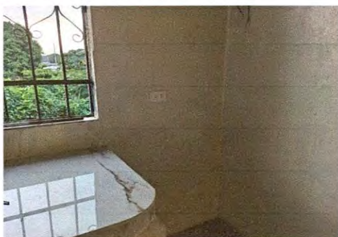
Foto 23: SUSTITUCIÓN DE TOMACORRIENTES DOBLES
