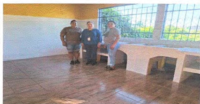
Foto 5: SUSTITUCIÓN DE PISO DE GRANITO
