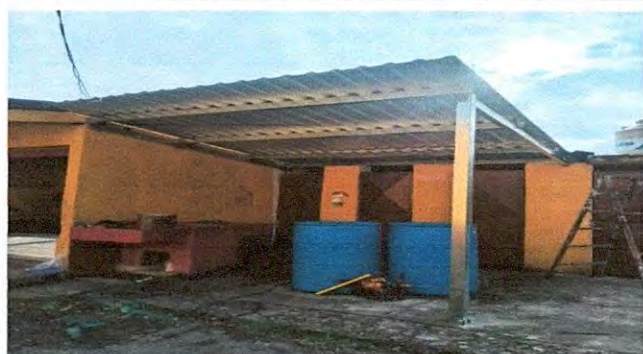
Foto 9: SUSTITUCIÓN DE LAMINA POR LAMINA TROQUELADA CALIBRE 26
