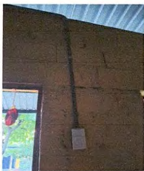
Foto 15: SUSTITUCIÓN DE INTERRUPTORES
