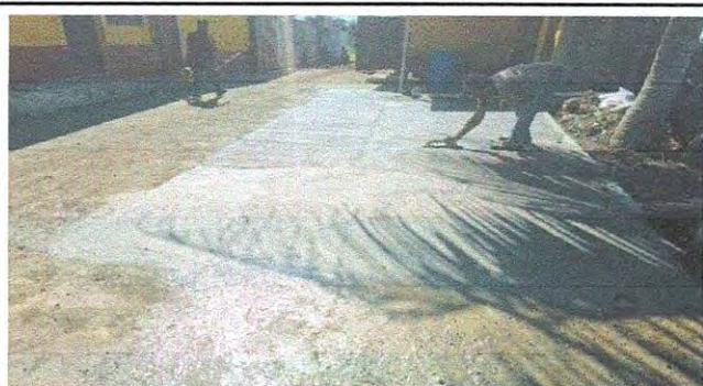
Foto 4: REPARACIÓN DE PLANCHA DE CONCRETO DE PATIO
