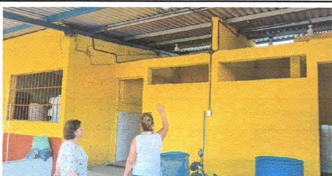
Foto 3: SUSTITUCIÓN DE FOCOS AHORRADORES
