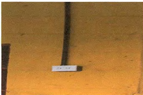
Foto 19: SUSTITUCIÓN DE TOMACORRIENTES DOBLES
