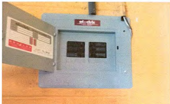
Foto 13: INSTALACIÓN DE TABLERO Y FLIPONES
