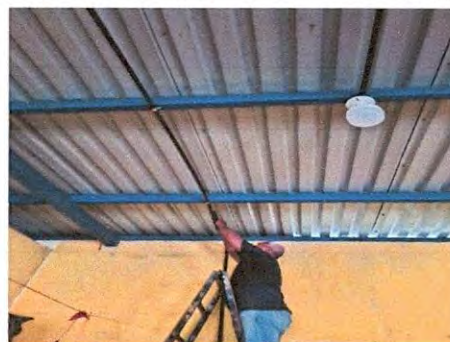
Foto 16: SUSTITUCIÓN DE PLAFONERAS
