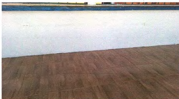
Foto 21: SUSTITUCIÓN DE TOMACORRIENTES DOBLES
