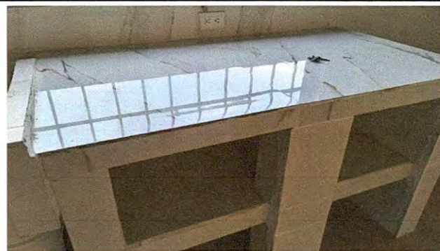
Foto 24: SUSTITUCIÓN DE AZULEJO
