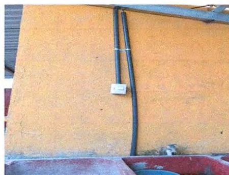
Foto 22: SUSTITUCIÓN DE INTERRUPTOR SIMPLE
