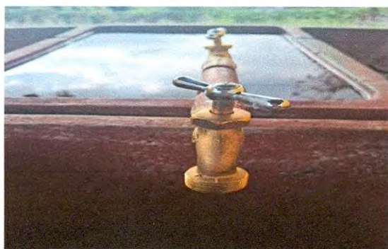
Foto 11: SUSTITUCIÓN DE LLAVE DE CHORROS
