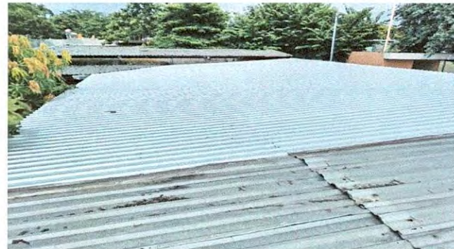
Foto 8: SUSTITUCIÓN DE LAMINA POR LAMINA TROQUELADA CALIBRE 26
