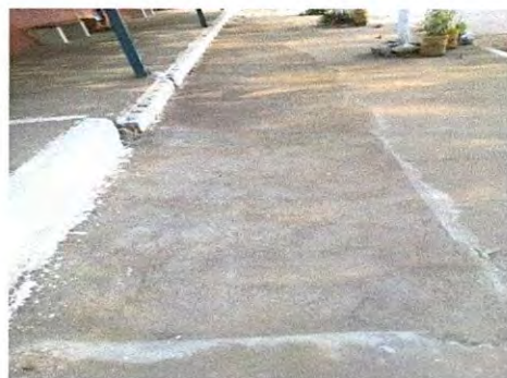
Foto 14: REPARACIÓN DE BANQUETA DE CONCRETO
