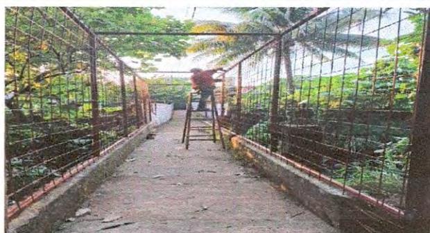
Foto 6: REPARACIÓN DE MURO PERIMETRAL
