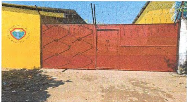
Foto 1: MANTENIMIENTO DE PORTÓN
