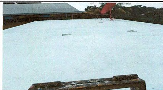
Foto 10: IMPERMEABILIZACIÓN DE LOSA
