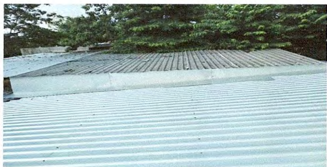
Foto7: SUSTITUCIÓN DE LAMINA POR LAMINA TROQUELADA CALIBRE 26
