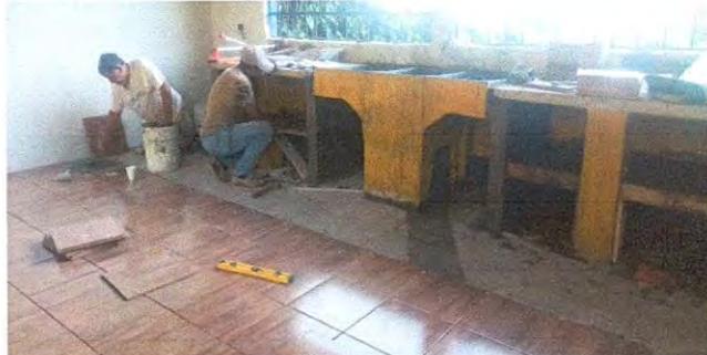
Foto 24: SUSTITUCIÓN DE PISO DE GRANITO
