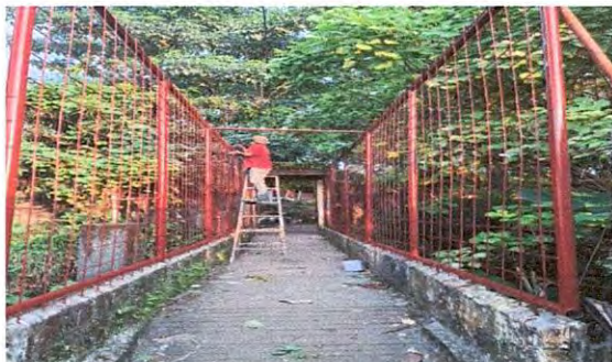
Foto 13: REPARACION DE TUBO HG MALLA GALBANIZADA
