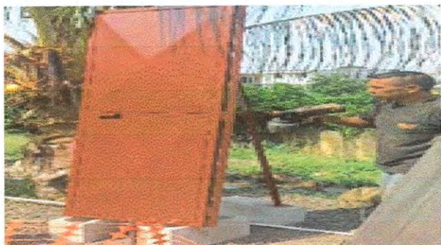
Foto 3: SUSTITUCION DE CHAPA
