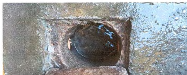
Foto 20: MANTENIMIENTO DE REPOSADERAS
