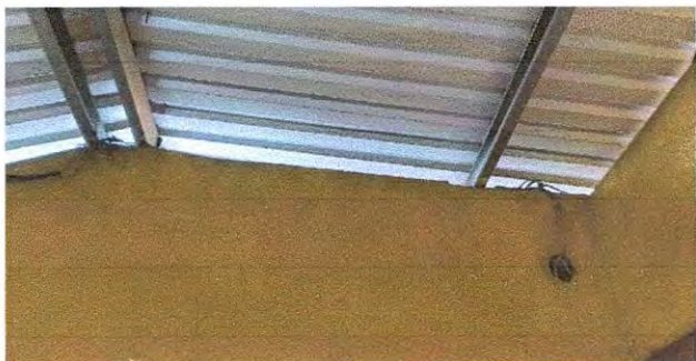
Foto 1: SUSTITUCION DE LAMINA POR LAMINA TROQUELADA
