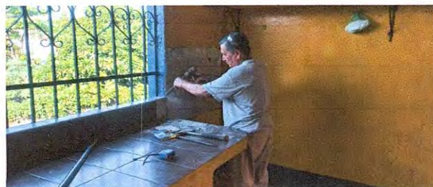
Foto 8: SUSTITUCIÓN DE AZULEJO
