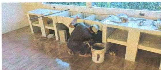
Foto 5: SUSTITUCION DE PISO DE GRANITO
