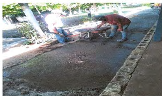
Foto 14: REPARACION DE PLANCHAS DE CONCRETO DE PATIO
