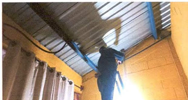
Foto 22: SUSTITUCION DE DUCTO ELECTRICO
