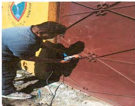
Foto 7: MANTENIMIENTO A PORTONES DE METAL
