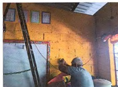
Foto 18: SUSTITUCION DE INTERRUPTORES DOBLES
