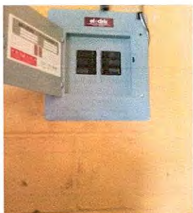
Foto 21: SUSTITUCION DE FLIPONES
