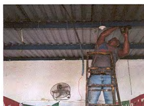
Foto 16: SUSTITUCION DE PLAFONERAS
