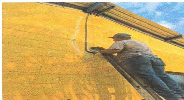
Foto 2: REPARACIÓN DE CABLEADO ELÉCTRICO
