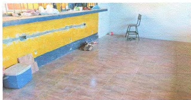
Foto 4: SUSTITUCION DE PISO DE CEMENTO LIQUIDO
