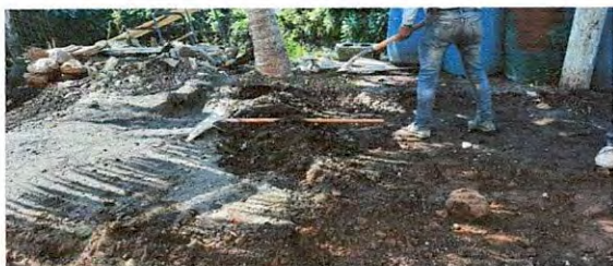
Foto 9: MANTENIMIENTO DE REPOSADERAS
