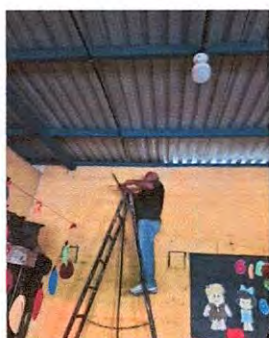
Foto 15: SUSTITUCION DE FOCOS AHORRADORES
