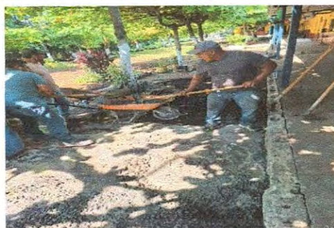
Foto 6: REPARACION DE BANQUETAS DE CONCRETO
