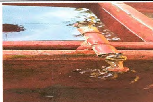
Foto 12: SUSTITUCIÓN DE LLAVE DE CHORRO
