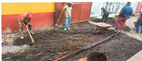
Foto 11: SUSTITUCION DE TUBERIA PRINCIPAL
