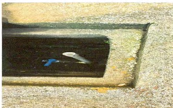
Foto 9: MANTENIMIENTO DE REPOSADERAS
