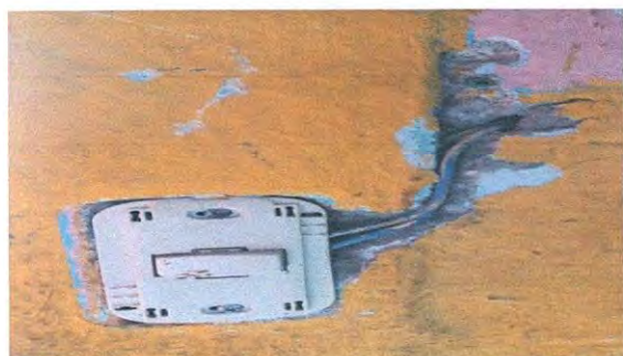
Foto 17: SUSTITUCIÓN DE INTERRUPTORES SIMPLES
