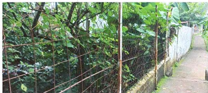
Foto 13: REPARACION DE TUBO HG MALLA GALBANIZADA
