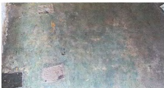
Foto 4: SUSTITUCION DE PISO DE CEMENTO LIQUIDO
