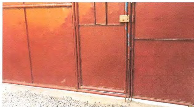
Foto7: MANTENIMIENTO A PORTONES DE METAL
