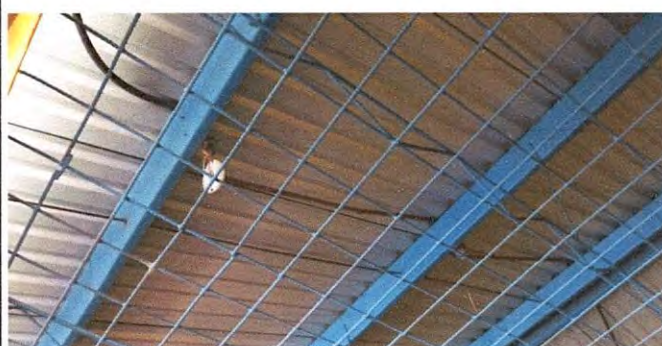
Foto 16: SUSTITUCION DE PLAFONERAS
