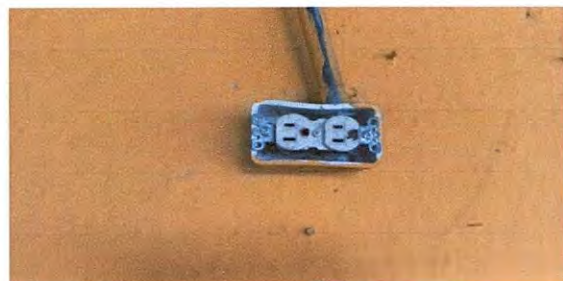
Foto 18: SUSTITUCION DE INTERRUPTORES DOBLES
