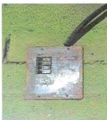
Foto 21: SUSTITUCION DE FLIPONES
