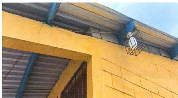
Foto 15: SUSTITUCION DE FOCOS AHORRADORES
