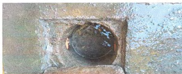
Foto 20: MANTENIMIENTO DE REPOSADERAS
