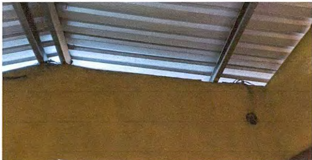
Foto 1: SUSTITUCION DE LAMINA POR LAMINA TROQUELADA
