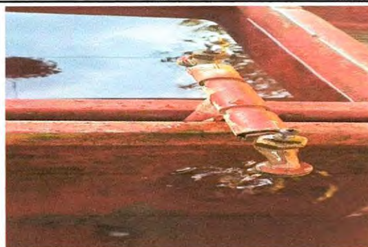
Foto 12: SUSTITUCIÓN DE LLAVE DE CHORRO
