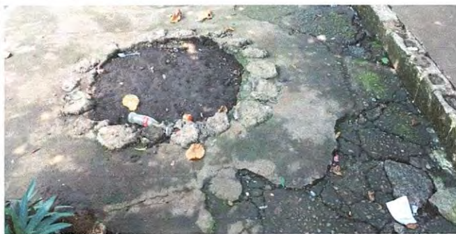
Foto 6: REPARACION DE BANQUETAS DE CONCRETO
