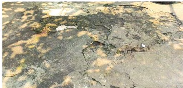
Foto 14: REPARACION DE PLANCHAS DE CONCRETO DE PATIO
