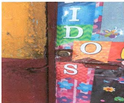
Foto 3: SUSTITUCION DE CHAPA
