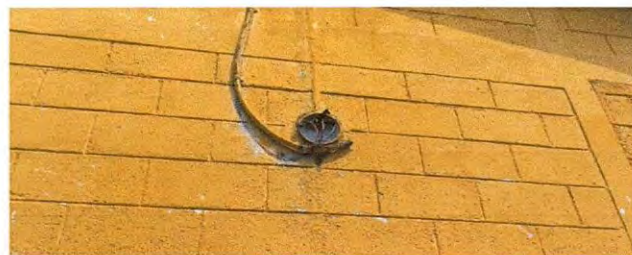
Foto 2: REPARACIÓN DE CABLEADO ELÉCTRICO
