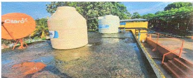
Foto 19: IMPERMEABILIZACION DE LOSA
