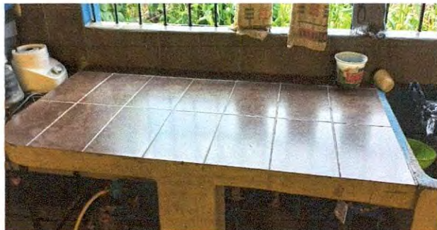
Foto 8: SUSTITUCIÓN DE AZULEJO
