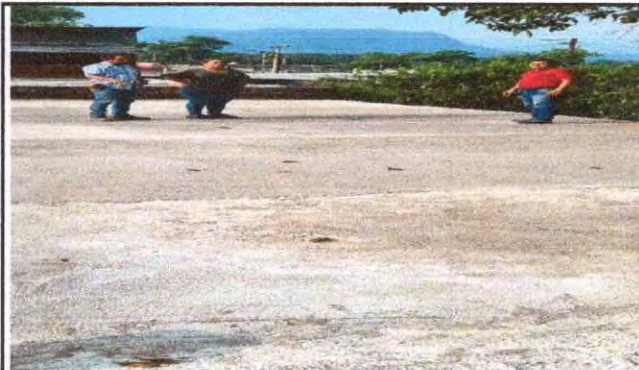
Foto 2: 3.2 Reparación de pañuelos.
