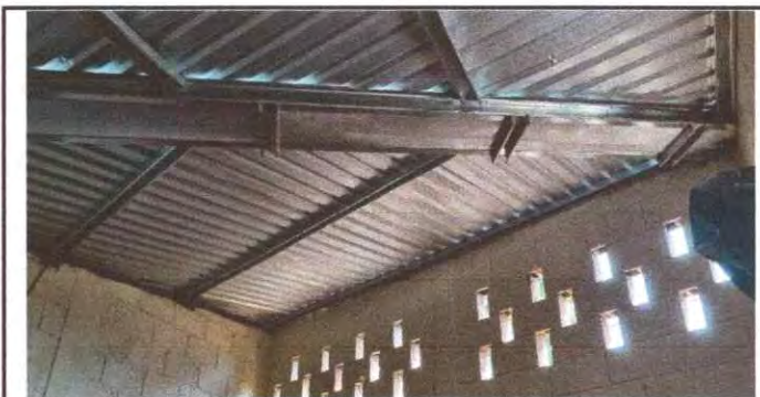
Foto 6. Sustitución de lámina troquelada aluzin calibre 26
