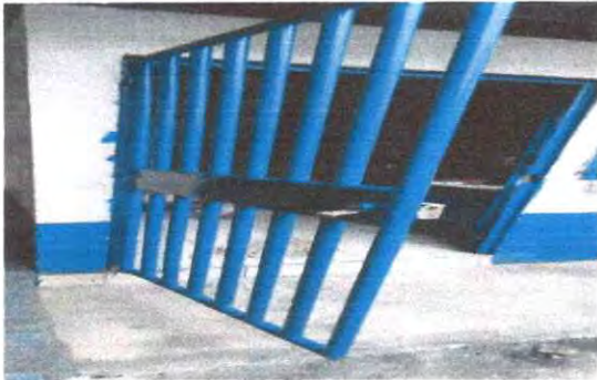
Foto 2.11.2 Sustitución de porton de metal.
