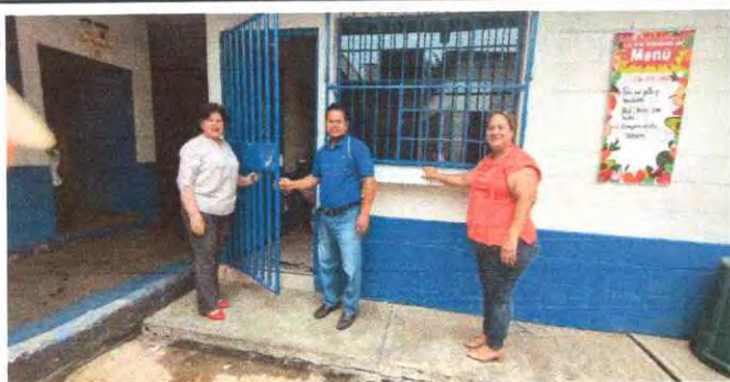
Foto : 4 11.2 Sustitución de porton de metal.
