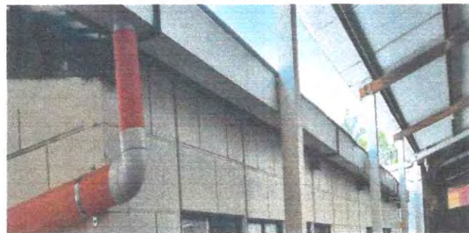
Foto : 7.1 Sustitucion de canal de metal
