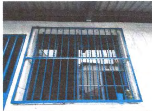
Foto 1: 5. 2 Sustitución de estructura de metal de ventana
