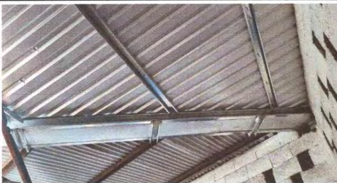
Foto 3 1.3 Sustitución de elementos de fijación
