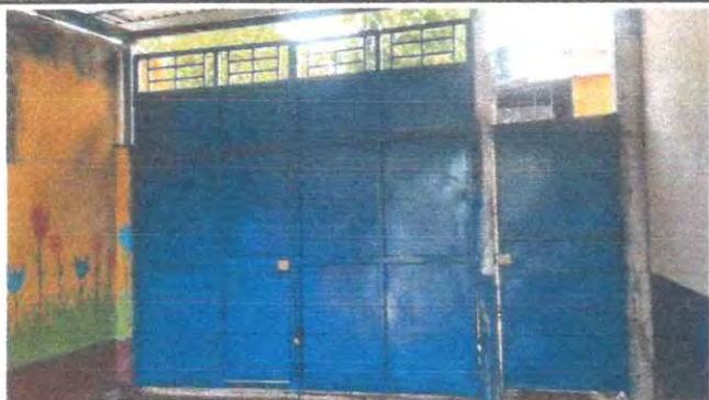
Foto 1: 4.5 sustitución de portón de metal
