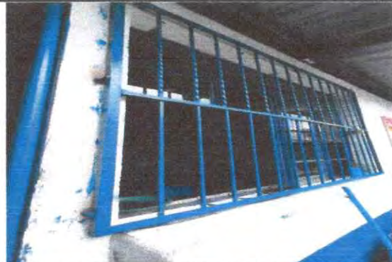
Foto 2: 5. 2 Sustitución de estructura de metal de ventana
