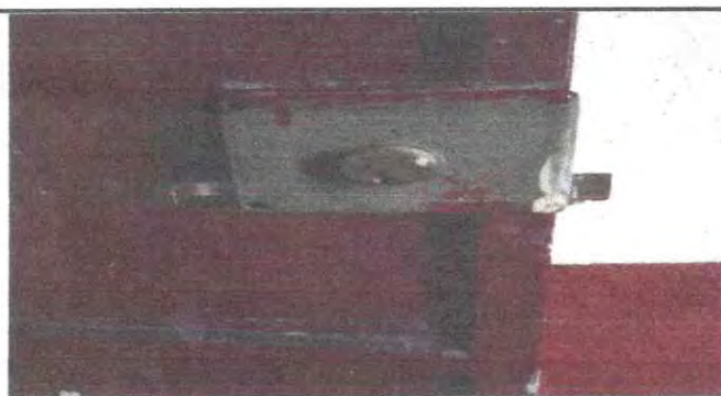
Foto 3 4.2 Sustitución de chapa
