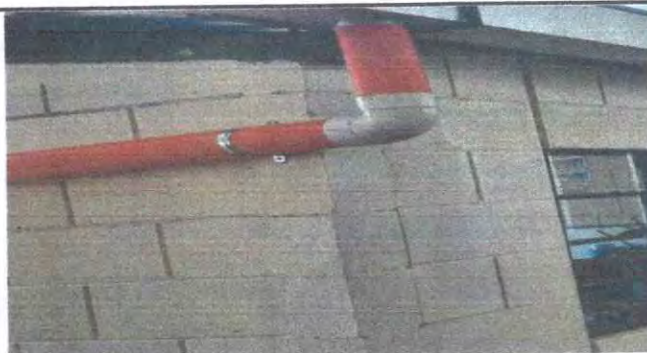
Foto 4: 7.2 sustitución de canal de pvc
