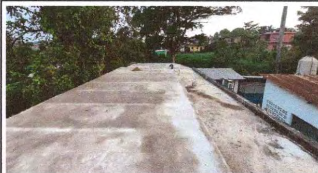
Foto 4: 3.2 Reparación de pañuelos.
