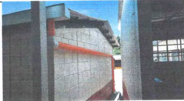
Foto 2: 47.2 sustitución de canal de pvc
