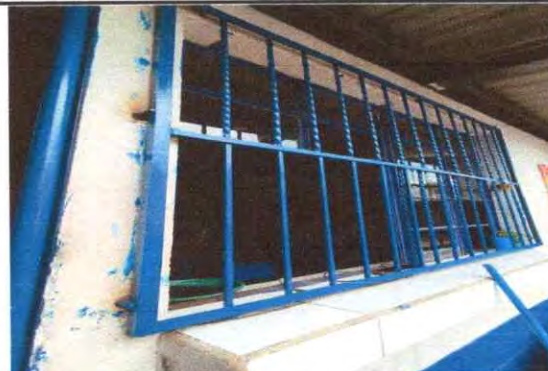
Foto 3: 5. 2 Sustitución de estructura de metal de ventana
