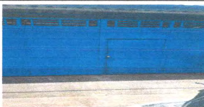
Foto 2: 4.5 sustitución de portón de metal
