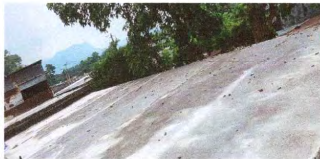
Foto 6: 3.2 Reparación de pañuelos.
