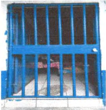
Foto 1.11.2 Sustitución de porton de metal.
