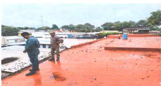
Foto 3 3.1 Impermeabilización de loza
