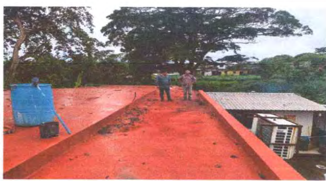
Foto 2: 3.1 Impermeabilización de loza
