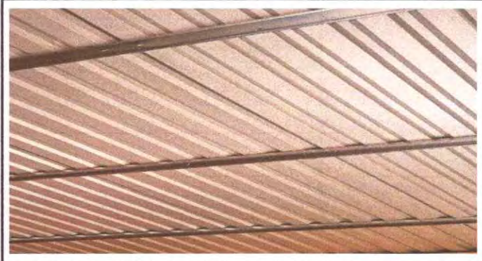
Foto 4: 1.3 Sustitución de elementos de fijación
