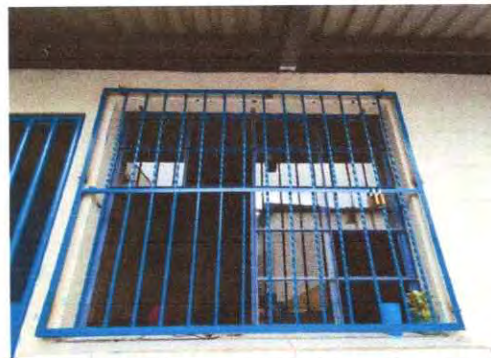
Foto 1: 5. 2 Sustitución de estructura de metal de ventana
