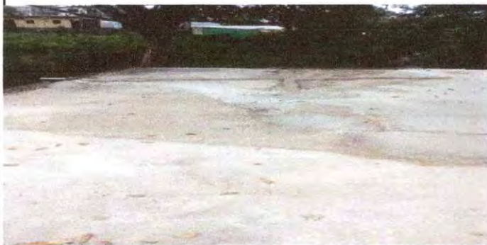
Foto 1: 3.2 Reparación de pañuelos.
