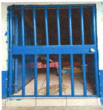
Foto 1 .11.2 Sustitución de porton de metal.
