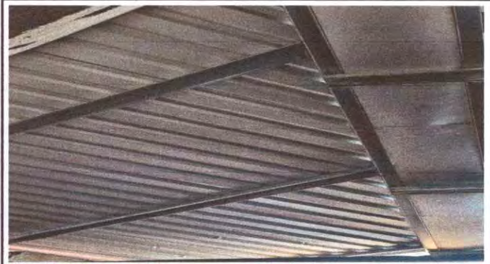
Foto 2: 2.3 Estructura de soporte de metal por metal
