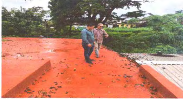
Foto 4: 3.1 Impermeabilización de loza
