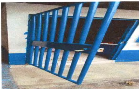
Foto 2 .11.2 Sustitución de porton de metal.
