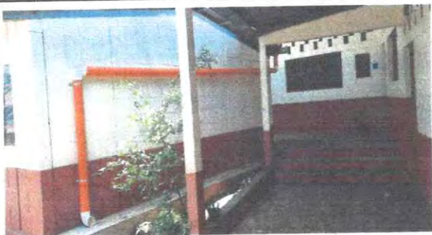
Foto 3: 7.2 sustitución de canal de pvc
