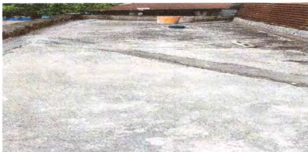
Foto 5: 3.2 Reparación de pañuelos.
