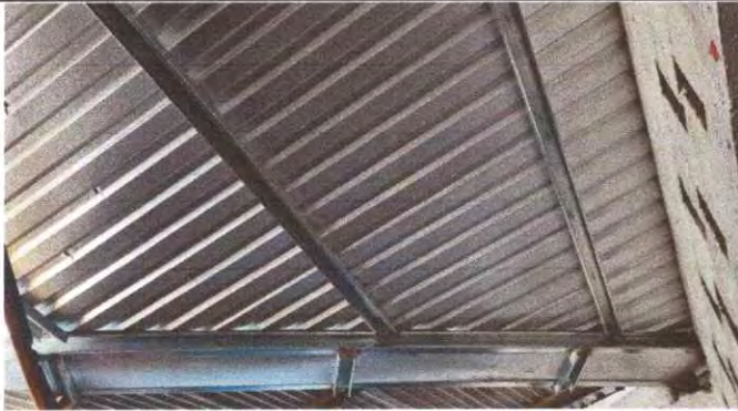
Foto 1: 2.3 Estructura de soporte de metal por metal
