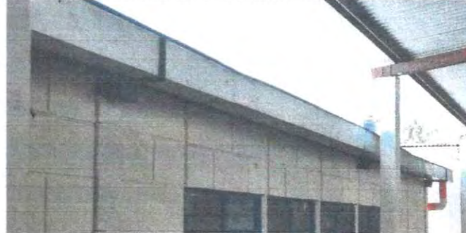
Foto 7.1 Sustitucion de canal de metal
