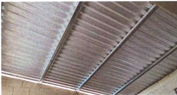
Foto : Sustitución de lámina troquelada aluzin calibre 26
