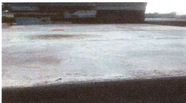
Foto 3: 3.2 Reparación de pañuelos.
