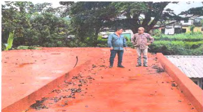
Foto 1: 3.1 Impermeabilización de loza
