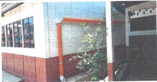
Foto 1: 7.2 sustitución de canal de pvc
