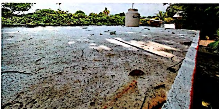
Foto 4: Impermeabilización de losa en el módulo de baños, finalizada al 100%
