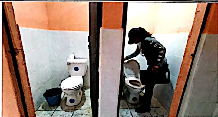
Foto 2: Cambio e instalación de inodoros, incluye accesorios y conexión de tubería. Finalizado al 100%
