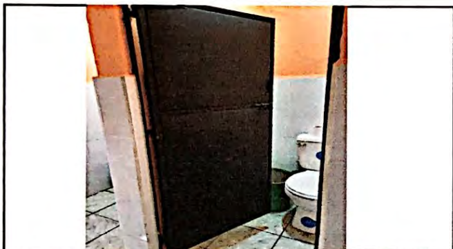
Foto 3: Herrería. Reparación y mantenimiento de puertas. (1.50 m x 0.69 m) en módulo de baños, finalizada al 100%
