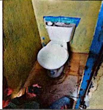
Foto 2: Avance en la ejecución de la instalación de nuevos inodoros en los servicios sanitarios.
