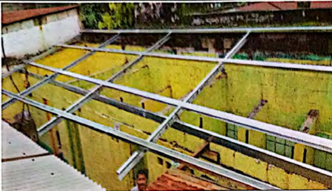
Foto 1: Se visualiza el cambio de la estructura metálica portante para proximamente la instalación de la nueva lamina toquelada aluzin calibre 26.
