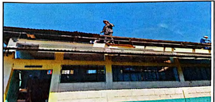
Foto 6: Proceso de desmontaje de lamina por fases en la cubiera del modulo de aulas. Proceso en ejecución.
