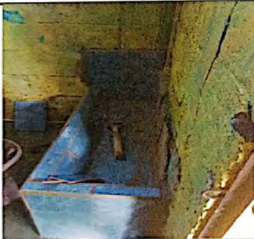
Foto 3: Instalación de azulejo en el área de mingitorio en proceso de ejecución.
