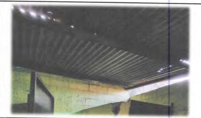
Foto 6: Cambio e instalación de lámina por lámina troquelada aluzinc calibre 26 (incluye pernos) en el módulo de baños.
