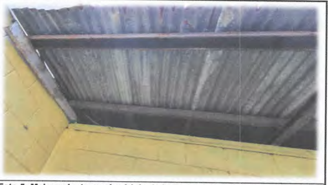
Foto 5: Mejoramiento en el módulo de baños con el cambio e instalación de estructura de soporte metal por metal
