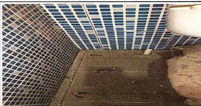
Foto 5: Instalación de tubo de abasto
