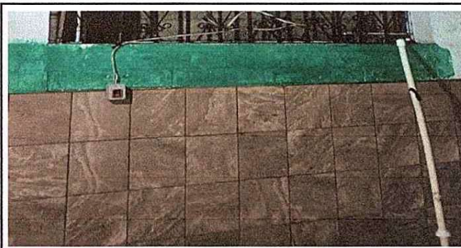
Foto 6: Sustitución de azulejo
