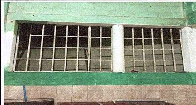
Foto 4: Sustitución de balcones
