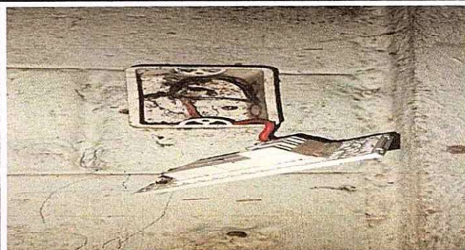
Foto 8: Sustitución de interruptores dobles
