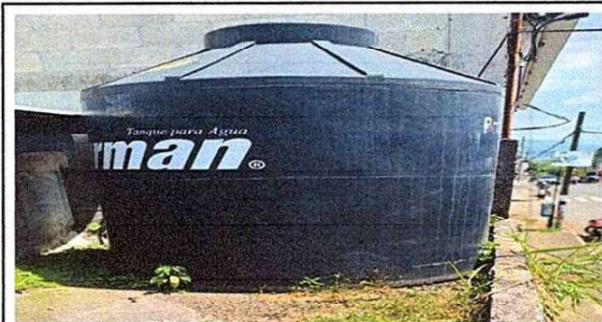
Foto 9: Sustitución de depósito de agua 1100lt
