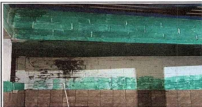
Foto 11: Repello en Muro
