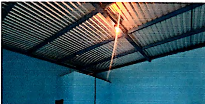
Foto 6: Suministro y reparación de sistema eléctrico, fuerza e iluminación en el módulo de salones de clase, finalizado al 100%.
