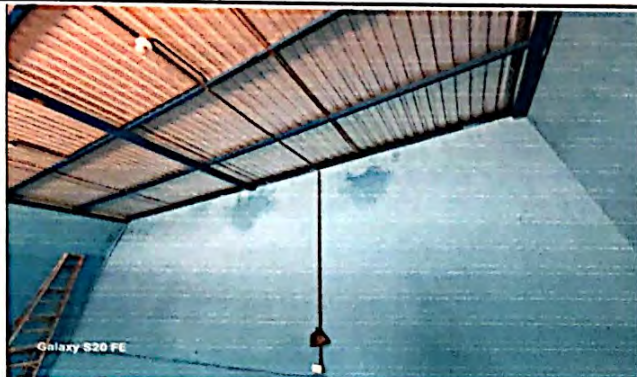
Foto 7: Suministro y reparación de sistema eléctrico, fuerza e iluminación en el módulo de salones de clase, finalizado al 100%.
