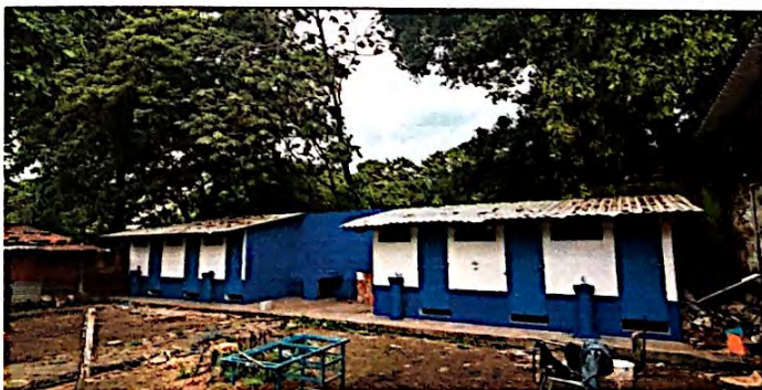
Foto 12: Reparación y mejoramiento en el área de servicios sanitarios (dos módulos), finalizada al 100%.
