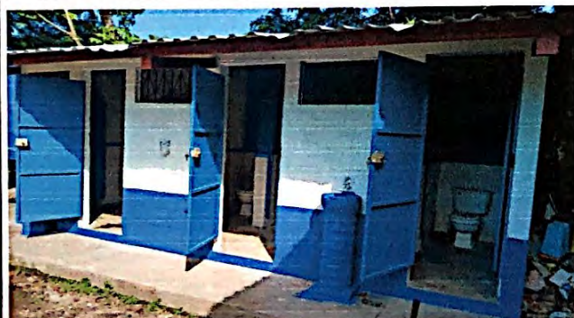
Foto 11: Reparación y mejoramiento en el área de servicios sanitarios, finalizada al 100%.
