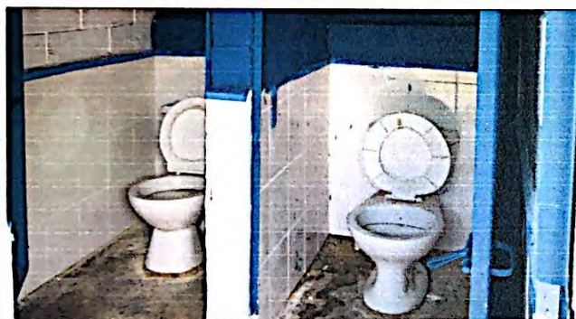
Foto 9: Cambio e instalación de inodoros en el módulo de baños, finalizada al 100%.
