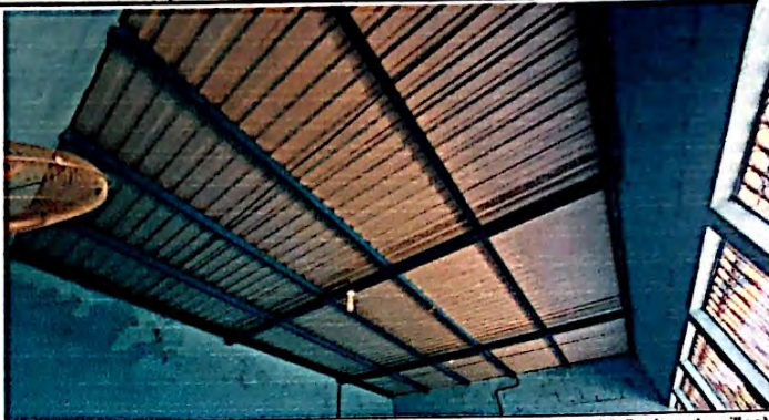
Foto 2: Suministro e instalación de lámina troquelada Aluzinc calibre 26 (incluye tornillos) en módulo de aulas, finalizado al 100%.
