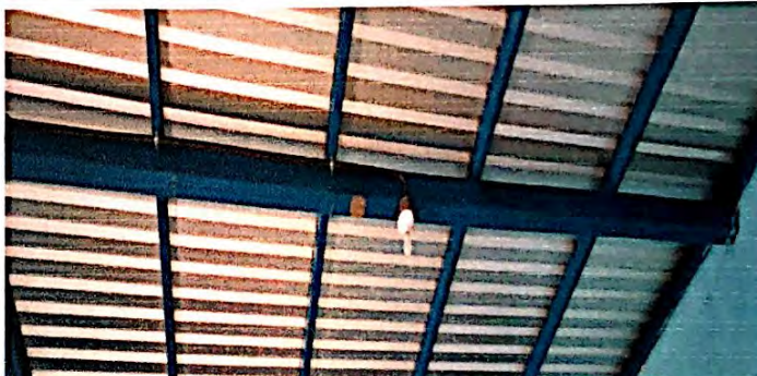
Foto 4: Mantenimiento a estructura de soporte de metal (lijado, aplicación a 2 manos de pintura anticorrosiva) en el módulo de aulas, finalizado al 100%.
