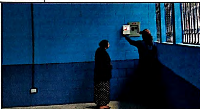
Foto 8: Suministro y reparación de sistema eléctrico, fuerza e iluminación en el módulo de salones de clase, incluye el cambio de caja de filipones. Finalizado al 100%.
