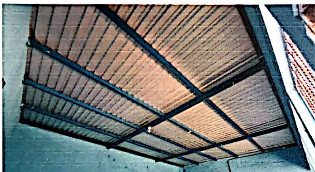
Foto 3: Suministro e instalación de lámina troquelada Aluzinc calibre 26 (incluye tornillos) en módulo de aulas, finalizado al 100%.
