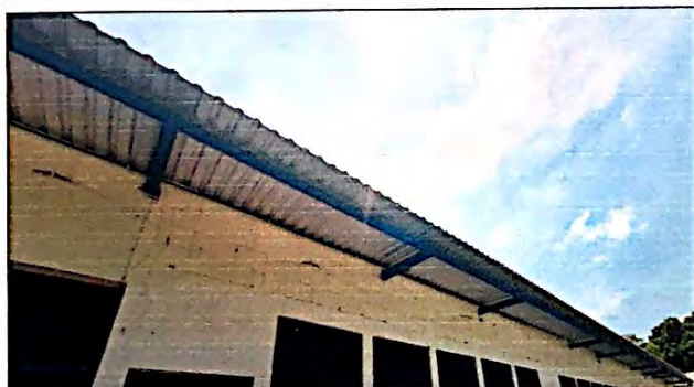
Foto 5: Mantenimiento a estructura de soporte de metal (lijado, aplicación a 2 manos de pintura anticorrosiva) en el módulo de aulas, finalizado al 100%.
