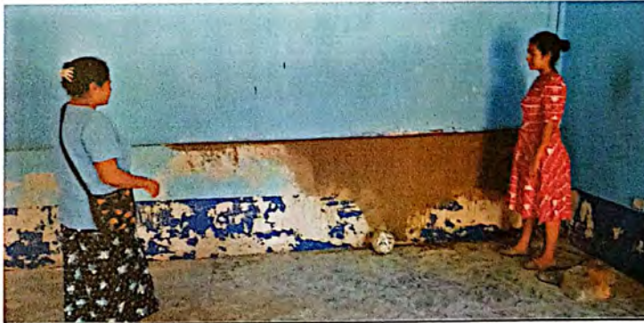
Foto 10: Trabajos de resanado en muros durante el proceso de remozamiento con pintura en el módulo de aulas.
