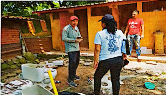
Foto 1: Evaluadora de campo en el recorrido para supervisar y evaluar el avance de los trabajos de remozamiento cuando estos tienen un avance del 50%
