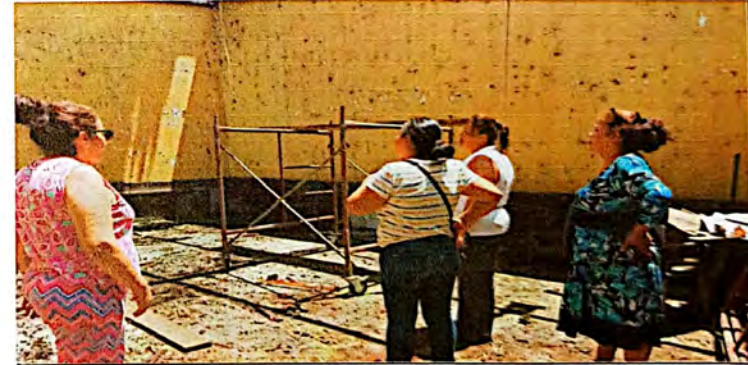
Foto 4: Suministro e Instalación de lámina troquelada Aluzinc calibre 26 (incluye tornillos). Uno de los módulos se encuentra en el proceso de desmontaje de la lámina.
