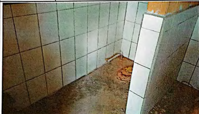
Foto 7: Con los remanentes luego del trabajo de techos se sustituyen los inodoros, se puede observar el espacio donde ya están desmontados los artefactos sanitarios.
