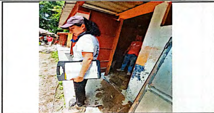
Foto 8: También se logran realizar trabajos de herrería con la reparación y sustitución de puertas metálicas en los módulos de baños, estos trabajos son supervisados por la evaluadora de campo.
