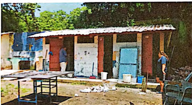
Foto 9: Como parte de los trabajos realizados con los remanentes se limpian los muros de los módulos de baños como parte del proceso de remozamiento con pintura interior y exterior.
