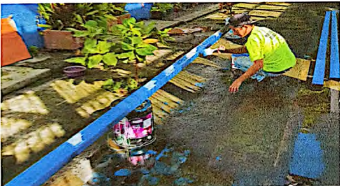
Foto 3: Mantenimiento a estructura de soporte de metal (lijado, aplicación a 2 manos de pintura anticorrosiva). Proceso de pintado para estructura de uno de los módulos de aulas.
