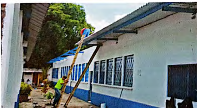
Foto 5: Suministro e Instalación de lámina troquelada Aluzinc calibre 26 (incluye tornillos). Uno de los módulos donde ya se encuentran realizando los trabajos de instalación de lámina.
