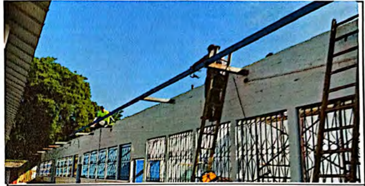
Foto 2: Mantenimiento a estructura de soporte de metal (lijado, aplicación a 2 manos de pintura anticorrosiva). Este trabajo se realizó en varios módulos de aulas pero no de manera simultanea, de tal manera que habían distintos avances en los módulos en el trabajo de remozamiento de techos.
