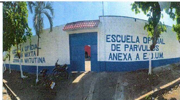
Foto 2: 9.1 PINURA EN MUROS EXTERIORES E INTERIORES
