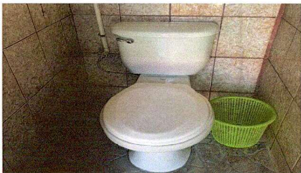
Foto 3: 10.3 SUSTITUCIÓN DE INODOROS
