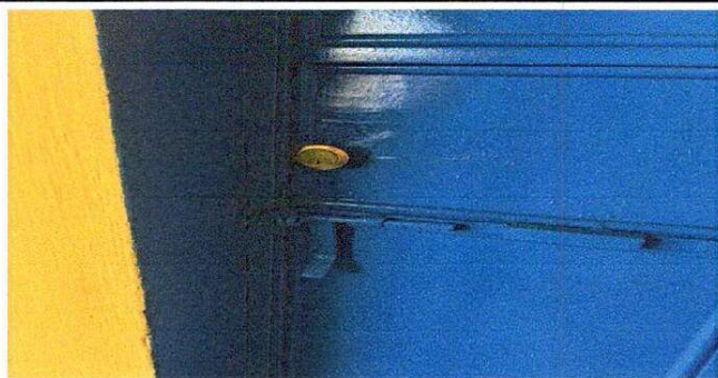
Foto1: 4.2 SUSTITUCIÓN DE CHAPAS
