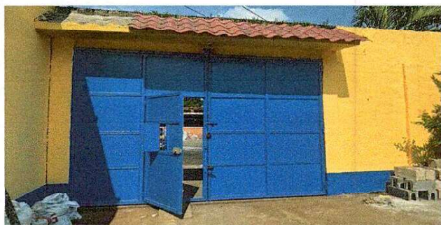
Foto 5: 12.1 MANTENIMIENTO A PORTONES
