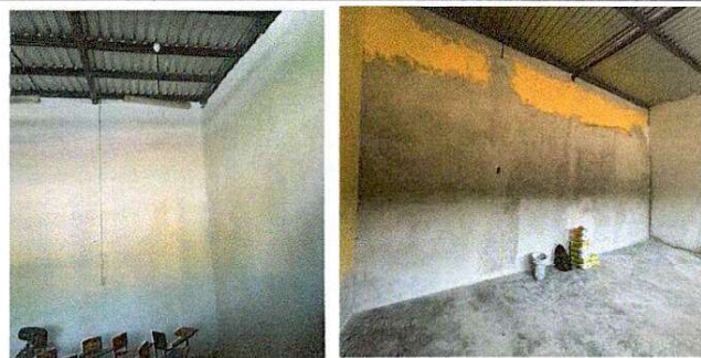
Foto 6: 21.1 REPELLO EN MURO
