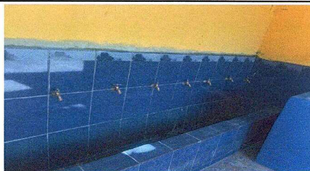
Foto 4: 14.13 SUSTITUCIÓN DE GRIFOS
