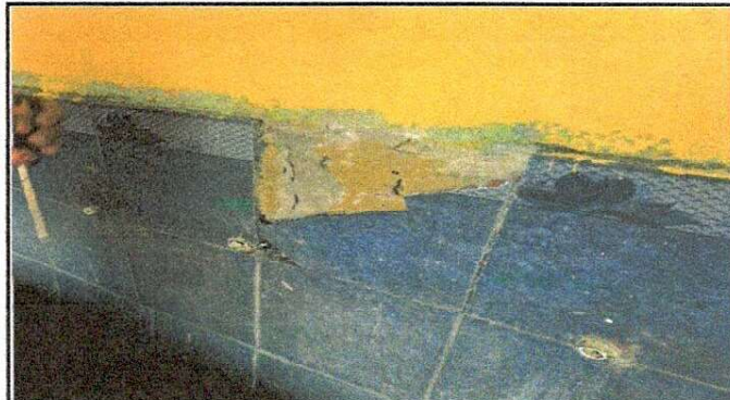
Foto 4: 14.13 SUSTITUCIÓN DE GRIFOS
