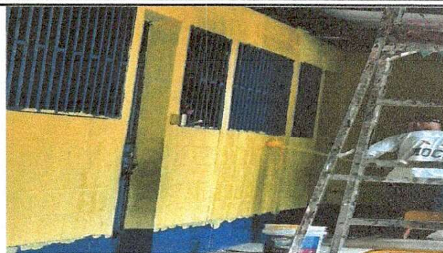
Foto 2: 9.1 PINURA EN MUROS EXTERIORES E INTERIORES
