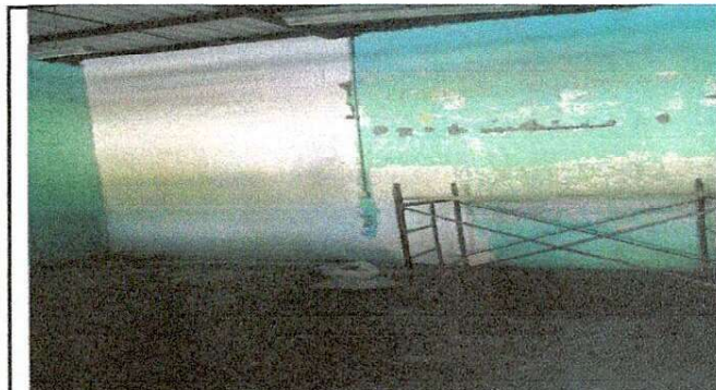
Foto 6: 21.1 REPELLO EN MURO
