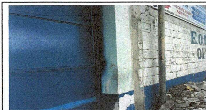
Foto 5: 12.1 MANTENIMIENTO A PORTONES
