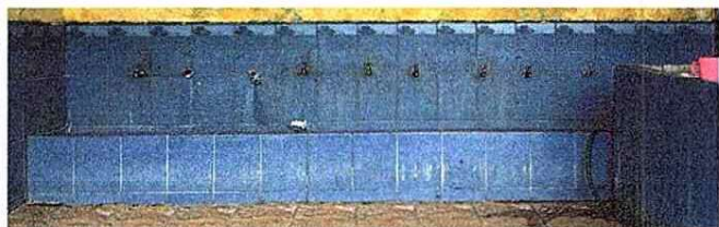
Foto 5: Sustitución de grifos
