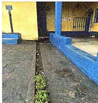
Foto 2: 8.1 Reparación de cuneta de concreto
