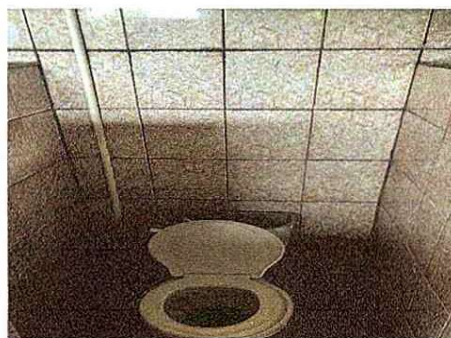
Foto 4: 10.3 Sustitución de Inodoro
