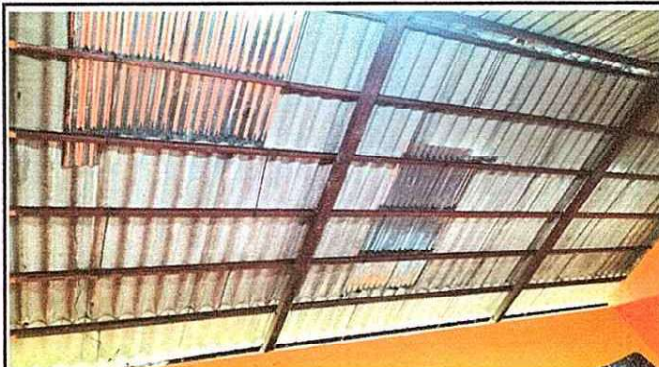
Foto 2. Sustitución de Estructura Metalica en Salón
