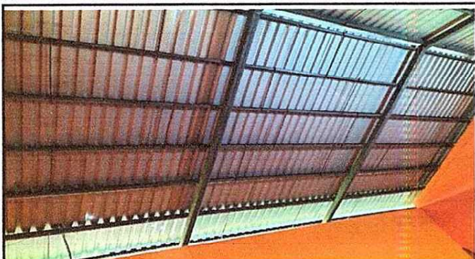
Foto 1. Sustitución de Lamina Troquelada Alizinc calibre 26
