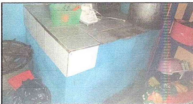
Foto 5: Sustitución de Azulejo
