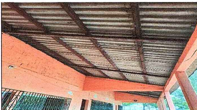
Foto 4. Sustitución de Estructura Metalica y sustitución de Lamina corredor
