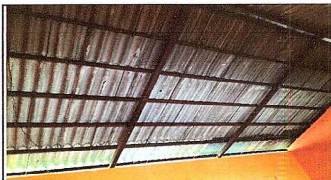
Foto 3. Sustitución de Estructura Metalica y sustitución de Lamina troquelada Aluzinc calibre 26 en salón
