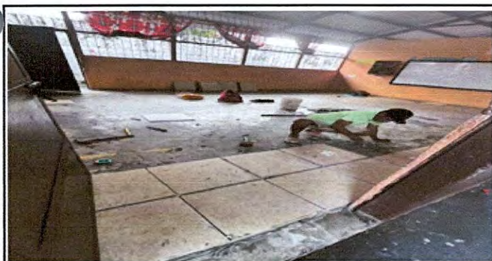
FOTO:5 Sustitución de piso Cerámico 50 %.
