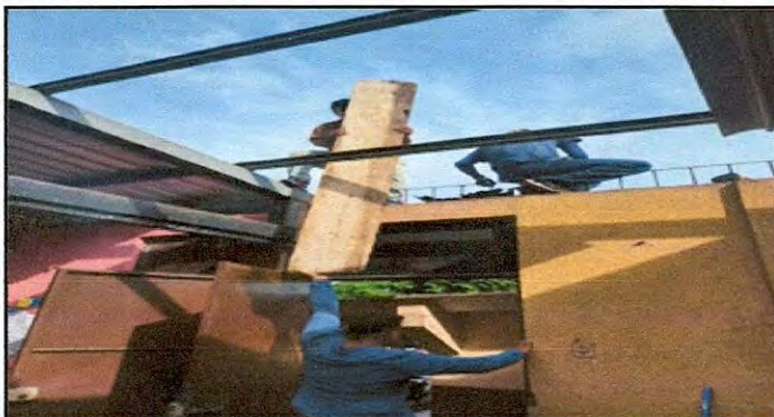
FOTO:1 Sustitución de lámina, por lámina Troquelada, Aluzinc Calibre 26. 50 %.
