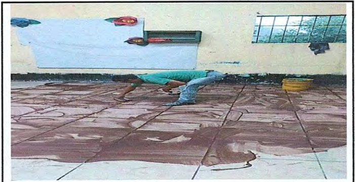
FOTO:6 Sustrucción de piso Cerámico 85%.
