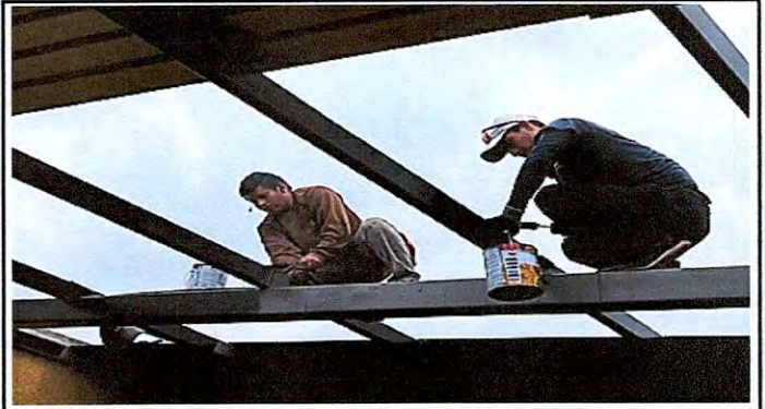
FOTO:4 Mantenimiento a estructura de Soporte de metal. 85%.
