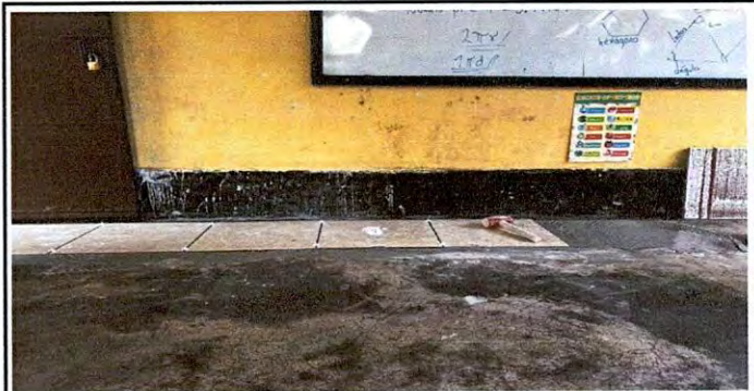
FOTO:6 Sustrucción de piso Cerámico 10%.
