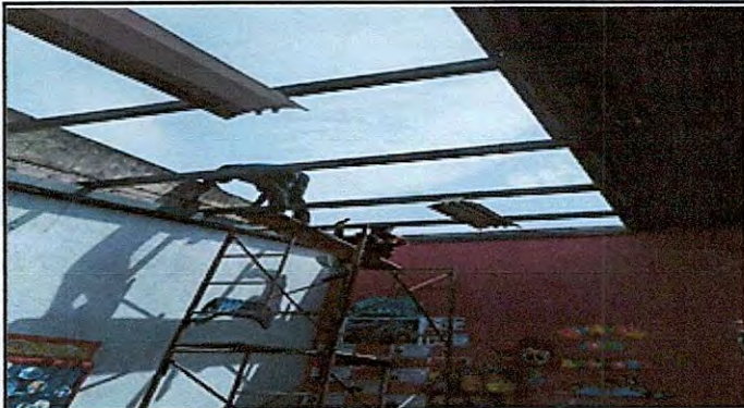
FOTO:3 Mantenimiento a estructura de Soporte de metal. 85%.
