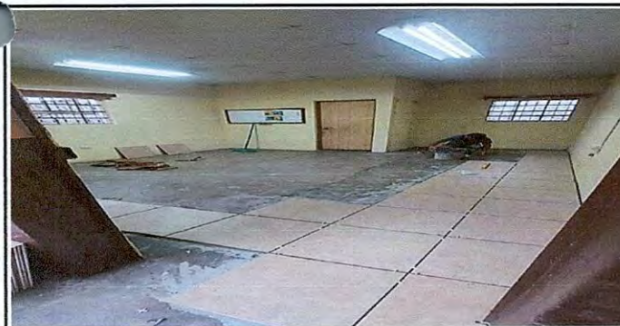
FOTO:5 Sustrucción de piso Cerámico 85%.
