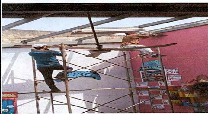
FOTO: 3 Mantenimiento a estructura de soporte de metal. 10%
