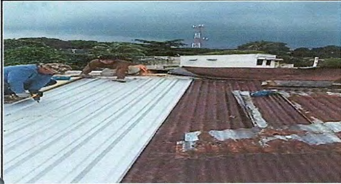
FOTO:1 Sustrucción, por lámina Troquelada, aluzinc calibre 26. 85%.
