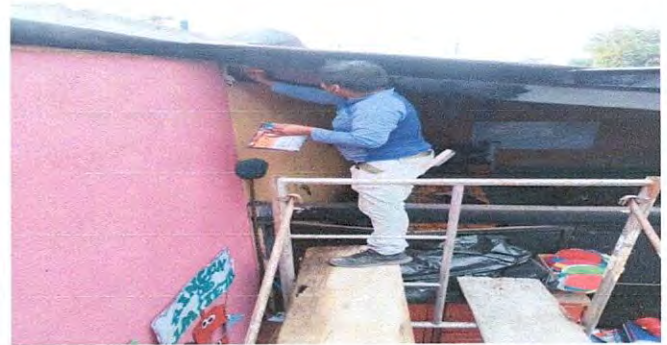
FOTO: 4 Mantenimiento a estructura de soporte de metal. 10%
