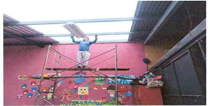
FOTO:2 Sustrucción de lámina, por lámina Troquelada, Aluzinc Calibre 26. 10 %
