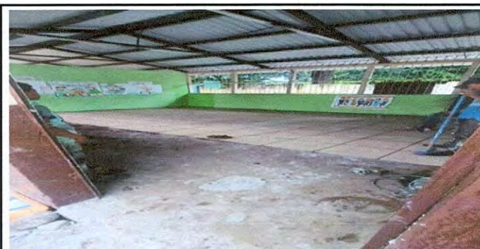
FOTO: 6 Sustitución de piso Cerámico 50 %.
