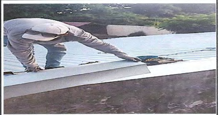
FOTO:2 Sustrucción, por lámina Troquelada, aluzinc calibre 26. 85%.
