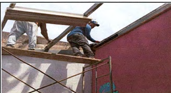
FOTO: 4 Mantenimiento a estructura de soporte de metal. 50 %.
