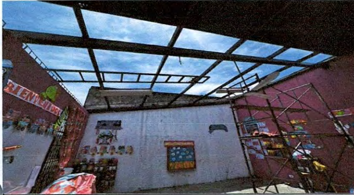
FOTO:1 Sustrucción de lámina, por lámina Troquelada, Aluzinc Calibre 26. 10 %
