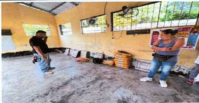
FOTO:5 Sustrucción de piso Cerámico 10%.
