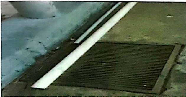
Foto 11: Podemos observar el material de tubo de PVC para la sustitución de bajadas de agua pluvial.
