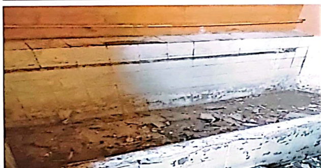
Foto 3: Desinstalación de azulejo en mal estado en el área de mingitorio, para instalar el nuevo azulejo. En el 1r. modulo de servicios sanitarios.
