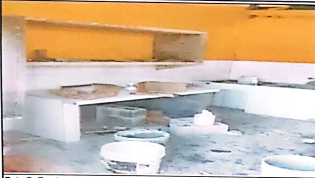
Foto 7: En el modulo de cocina se observa el avance de ejecución en muebles fijos cocina, instalación de azulejo como tambien de piso ceramico antideslizante.
