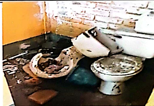
Foto 2: Desmontaje de inodoros en mal estado en el primer modulo de servicios sanitarios, avance en su proceso de ejecución.
