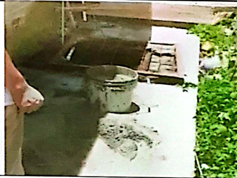
Foto 8: Se tiene en proceso de mejoras la tapadera de concreto en el área de pozo.
