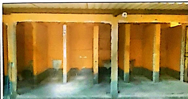
Foto 5: Demodificación de muros en el área del segundo modulo de servicios sanitarios, así mismo el desmontaje de los inodoros, para instalar azulejo y piso cerámico antideslizante.
