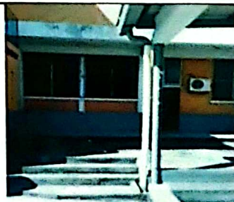
Foto 12: Reparacion en fases de ejecución, bajadas de agua pluvial con tubo de PVC mas abrazadera para sostener las bajadas de agua con columna.
