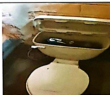
Foto 4: Se observa que se tiene avance en el cambio del kit de accesorios de algunos servicios sanitarios, en el primer modulo de servicios sanitarios.
