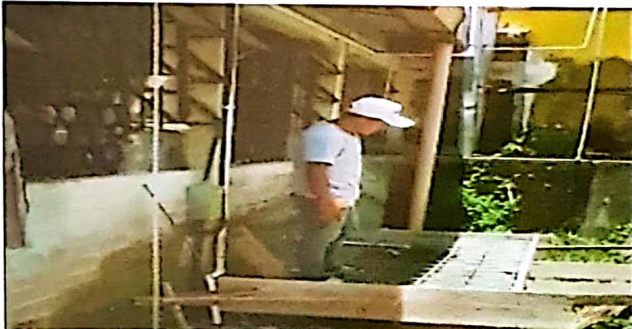
Foto 9: Asi mismo se ve el proceso de ejecución del avance, armado de losa de concreto para cisterna de agua.
