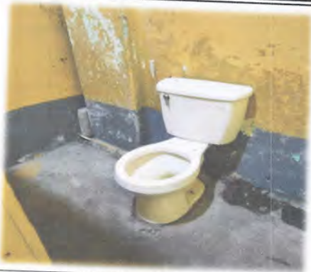
Foto7: Mejoramiento en el 3er. módulo de servicios sanitarios, incluye reparación, cambio de tubería, arefactos y azulejo
