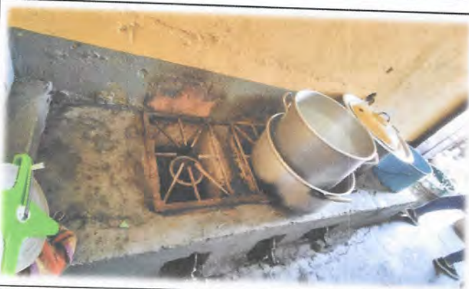
Foto 9: Mejoramiento de cocina incluye estufa de leña rural más chimenea.
