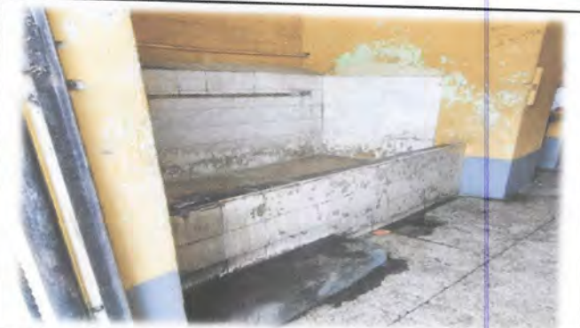
Foto 6: Mejoramiento en el 2do. módulo de servicios sanitarios, incluye reparación, cambio de tubería, arefactos y azulejo.
