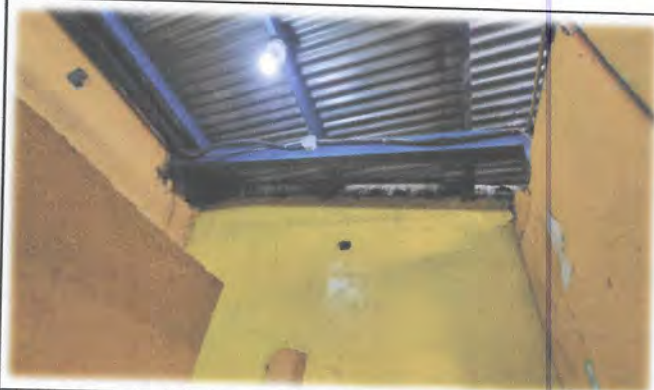
Foto 4: Mejoramiento en el 1er. módulo de servicios sanitarios, reparación de circuito de iluminación y fuerza, incluye accesorios.
