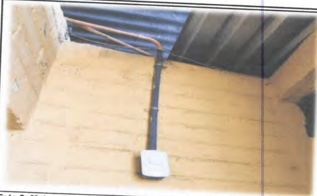
Foto 8: Mejoramiento en el 3er. módulo de servicios sanitarios, reparación de circuito de iluminación y fuerza, incluye accesorios.
