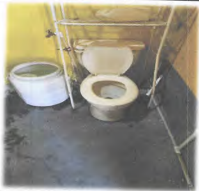
Foto 3: Mejoramiento en el 1er. módulo de servicios sanitarios, incluye reparación, cambio de tubería, arefactos y azulejo.
