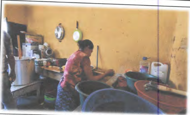
Foto 10: Mejoramiento de cocina incluye remozamiento de muebles de cocina, azulejo.
