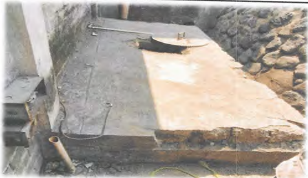
Foto 11: Se presenta necesidad de reparación de la losa superior de la sisterna.
