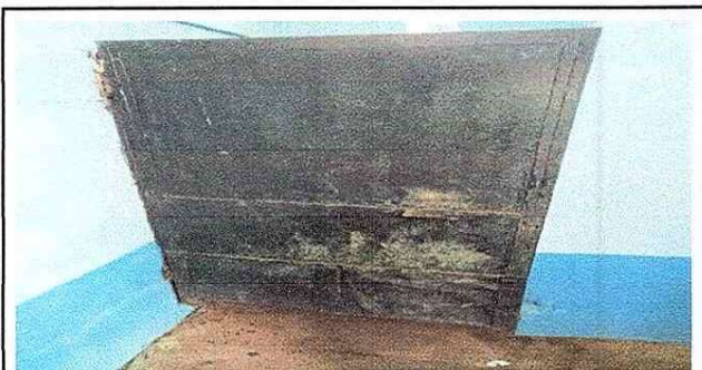
FOTO 3: MANTENIMIENTO DE PUERTAS DE SALONES
