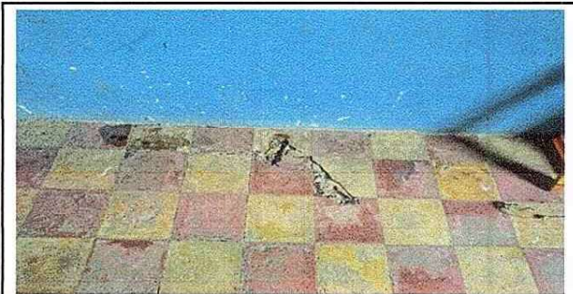
FOTO 5: SUSTITUCIÓN DE PISO CERÁMICO
