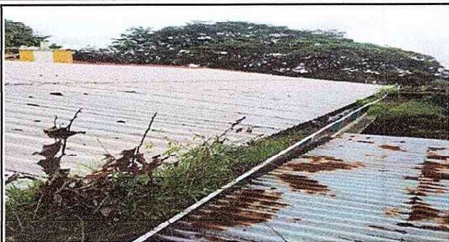
FOTO 1: SUSTITUCIÓN DE LAMINA POR LAMINA TROQUELADA ALUZINC CALIBRE 26 ÁREA DE COCINA
