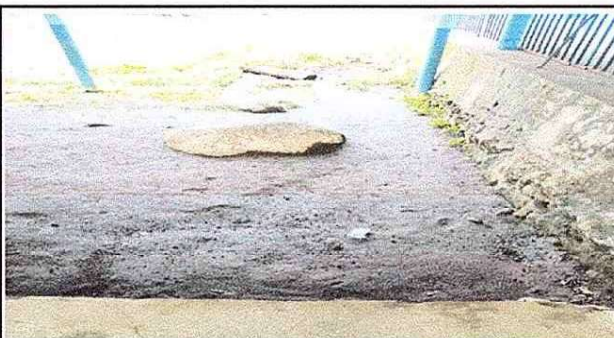
FOTO 4: REPARACIÓN DE PISO DE TORTA DE CONCRETO
