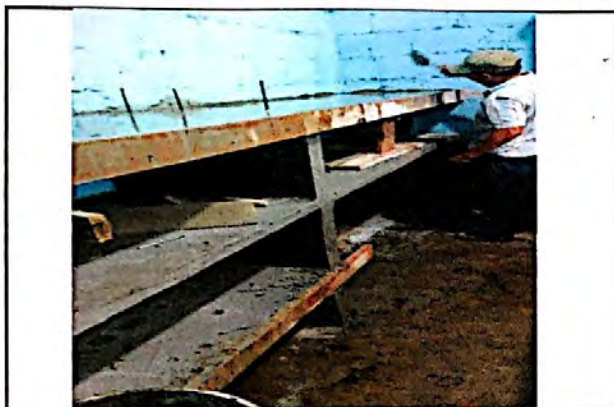
Foto 3: En el modulo de cocina se avanza con la fundicion de concreto reforzado de muebles fijos..
