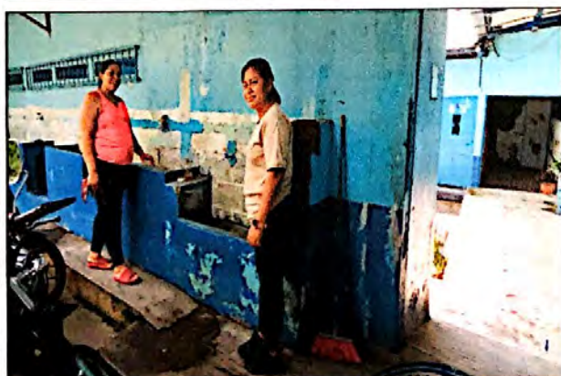
Foto 5: Se prepara la superficie donde se instalará el azulejo en lavamanos ubicado en el primer patio. Trabajo adicional a la PRA-FOR-85. OPF presente en el recorrido.
