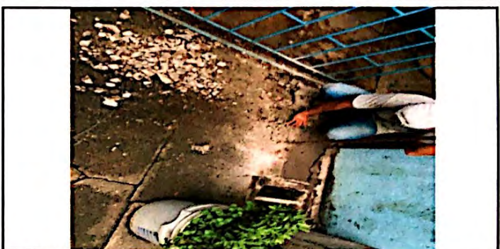
Foto 4: Reparación de torta de concreto para la instalación y sustitución de piso cerámico antideslizante.
