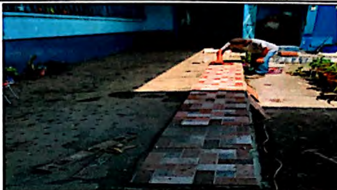
Foto 2: Cambio e instalación de piso antideslizante en corredor patio No. 2 en su avance de ejecución.
