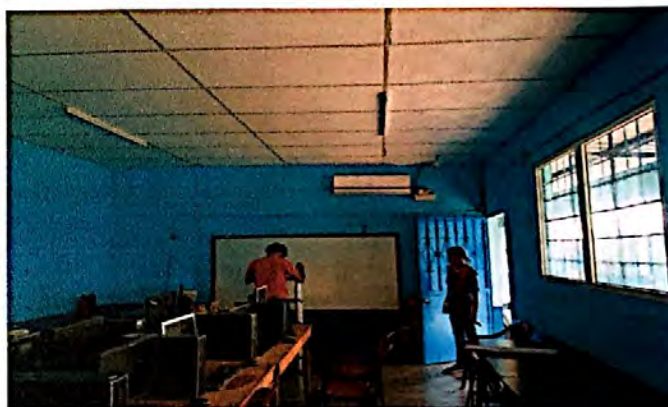
Foto 4: Avance de reparación de sistema electrico en aulas, cabe mencionar que es un trabajo adicional de la PRA-FOR-85.
