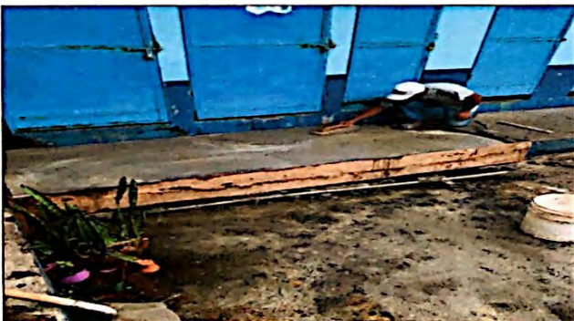
Foto 5: Reparación de banqueta en modulo de servicios sanitarios de hombres en su avance de ejecución.
