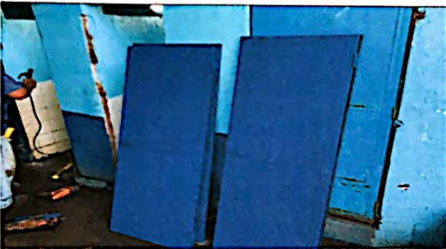
Foto 3: Proceso de reparación y mantenimiento de puertas de metal en el modulo de servicios sanitarios de niñas.
