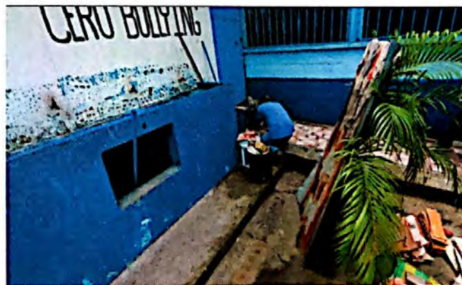
Foto 6: Se prepara la superficie donde se instalará el azulejo en lavamanos ubicado en el segundo patio. Trabajo adicional a la PRA-FOR-85. OPF presente en el recorrido.
