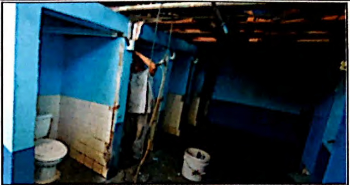
Foto 2: Módulo de servicios sanitarios en proceso de ejecución. Desmontaje de puertas metálicas en cubículos de servicios sanitarios de mujeres.
