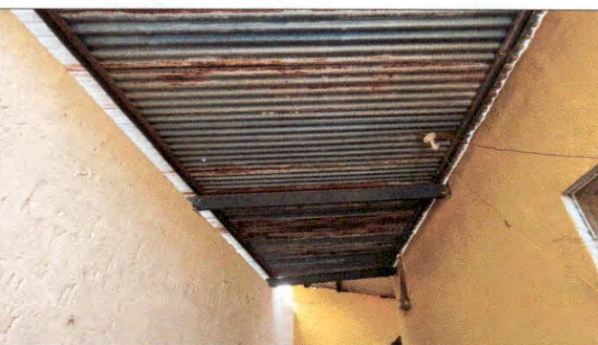
Foto 5: En el área de lavamanos, es necesario dar mantenimiento a la estructura de soporte y el cambio e instalación de lámina, por lámina troquelada aluzinc calibre 26 (incluye tornillos)
