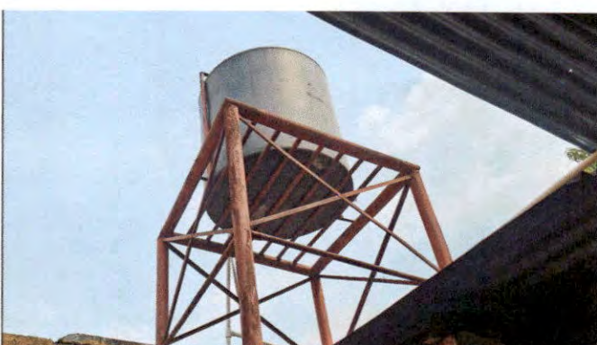
Foto 6: Es necesario el cambio e instalación de deposito de agua 1250 lts incluye accesorios y conexiones.
