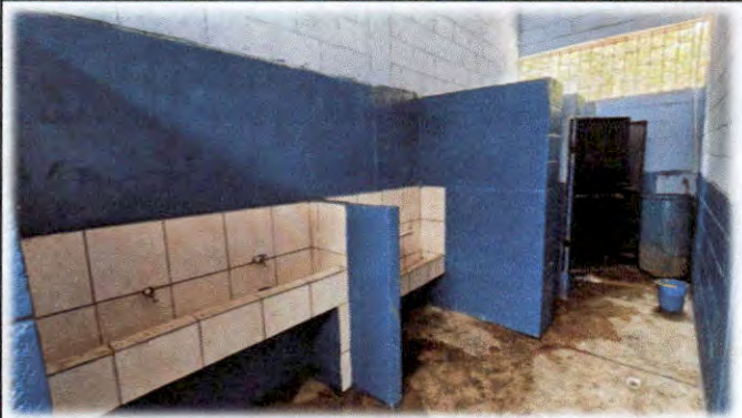
Foto 7: Mejoramiento de servicio sanitario, incluye reparación, cambio de tubería y artefactos, cambio e instalación de azulejos y cambio e instalación de piso antideslizante.
