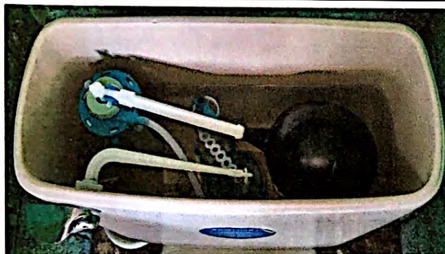
Foto 3: Cambio e instalación de kit de inodoro, finalizado al 100%.
