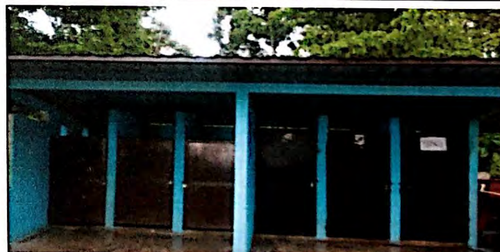
Foto 4: Reparación de estructura vertical y horizontal (columnas y vigas) en el área de servicios sanitarios, finalizada al 100%.
