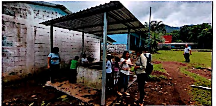
Foto 12: Suministro y montaje de galera en pileta al costado de modulo de cocina Finalizado al 100%. Cabe mencionar que es trabajo extra llamado tambien remanente.
