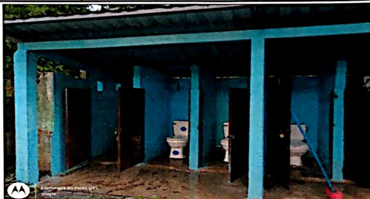
Foto 2: Cambio e instalación de inodoros, cambio e instalación de estructura portante mas lamina troquelada aluzinc calibre 26, finalizado al 100%.
