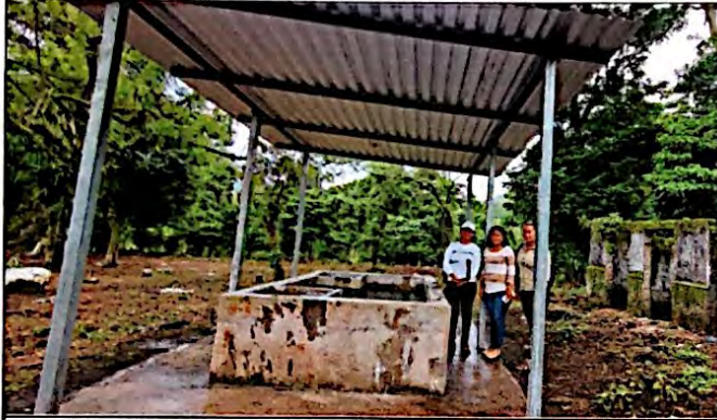
Foto 7: Suministro e instalación de estructura de soporte de madera por metal y suministro e instalación de lámina por lámina troquelada de aluzinc calibre 26, en el área de piletas cerca de los servicios sanitarios, finalizado al 100%.
