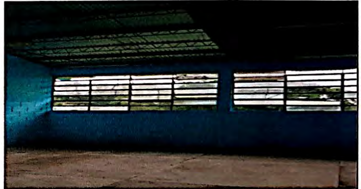
Foto 8: Suministro e instalación de lámina troquelada aluzinc calibre 26 en salón de clases, finalizado al 100%.
