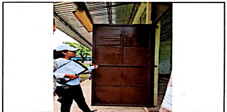
Foto 10: Cambio e instalación de puerta metálica en aula, finalizado al 100%.
