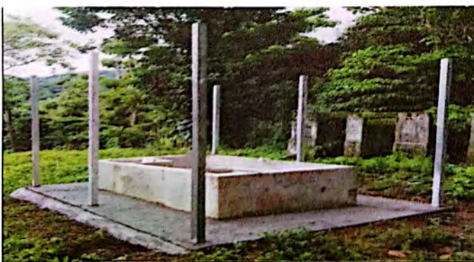
Foto 5: Se observa el avance de la ejecución de la galera para la protección de pileta que se encuentra lado Norte del establecimiento.
