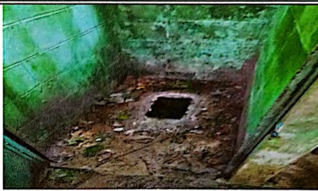
Foto 2: Reparación en el primer modulo extracción de inodoro deteriorado y limpieza en paredes y en piso de concreto en el primer modulo de servicios sanitarios, proceso de ejecución.
