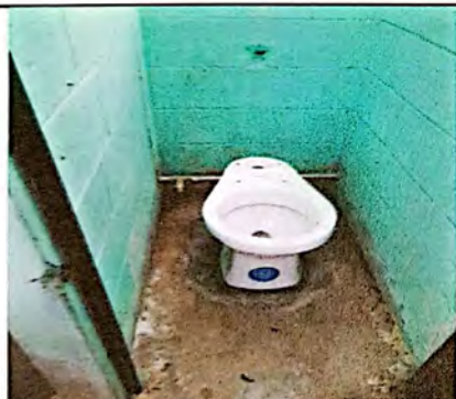
Foto 3: Se visualiza la instalación de algunos inodoro en el primer modulo de servicios sanitarios.
