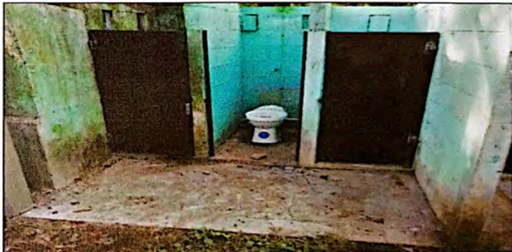
Foto 4: Se visualiza avance en la instalación de nuevas puertas en los cubiculos de los servicios sanitarios.
