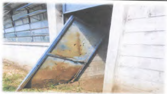
Foto 7: Mejoramiento y Reparaciones en el modulo de cocina y bodega. También incluye cambio de puerta de metal en bodega y balcon.
