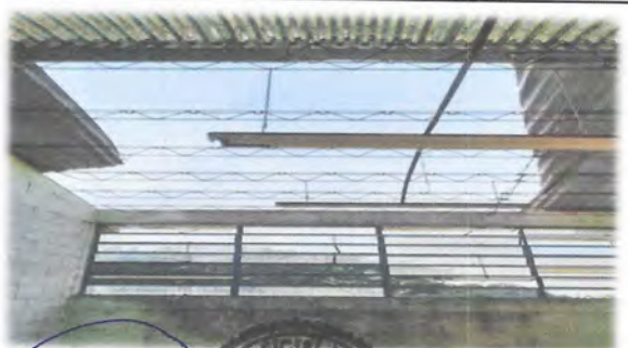
Foto 11: Sustitución e instalación de cuatro laminas troqueladas aluzinc calibre 26. Por cuestiones de clima y mala sujecion ha sido movidas de la escuela Aldea.
