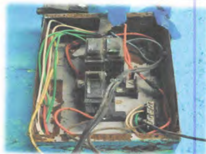
Foto 8: Mejoramiento de circuito electrico 250 mts, incluye cambios de varios accesorios como tambien tableros de flipones.
