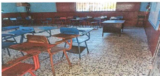
Foto 5 Sustitucion piso de granito en proceso salón 4 finalizado
