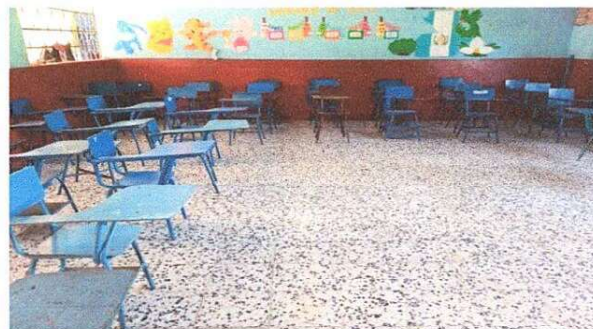
Foto 2: Sustitución de piso de granito salon 2 finalizado
