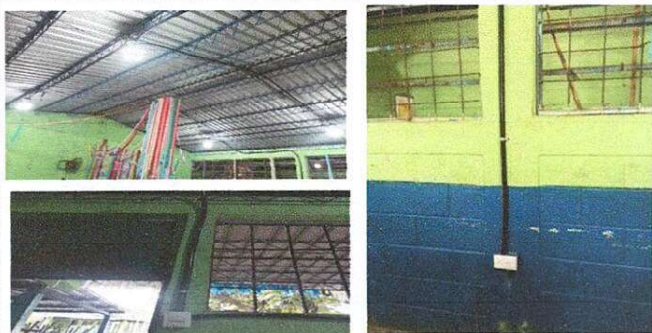
Foto 3: Sustitucion de sistema electrico salon 12 finalizado reparacion de cableado electrico que alimenta salones 9,10 y 11 finalizado
