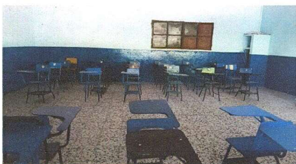
Foto1: Sustitucion piso de granito salon 1 finalizado
