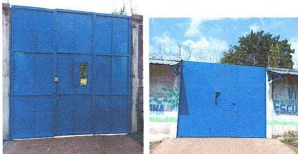
Foto 6: Mantenimiento de porton de metal finalizado
