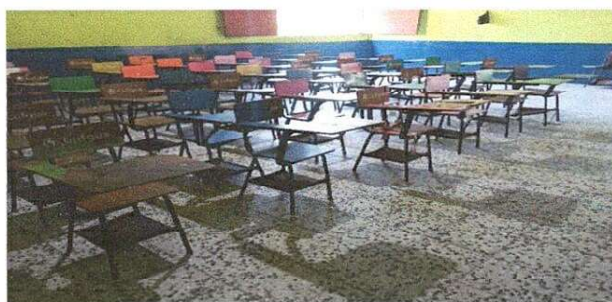
Foto 4: Sustitución de piso de granito salon 3 finalizado
