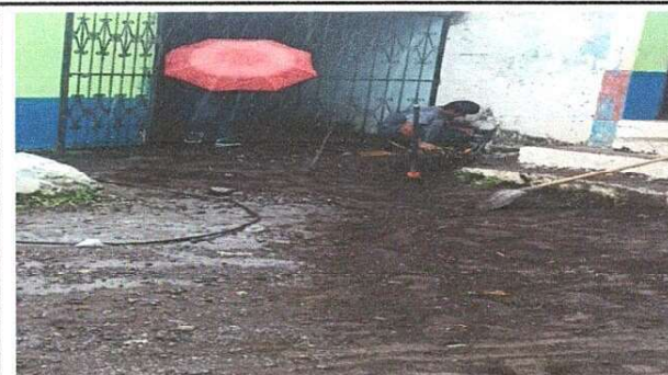
Foto 4: Sustitución del ducto eléctrico que conecta las aulas 9.10 y 11 en proceso
