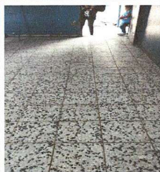
Foto 2: Salón 1 finalizado la sustitución de piso de granito
