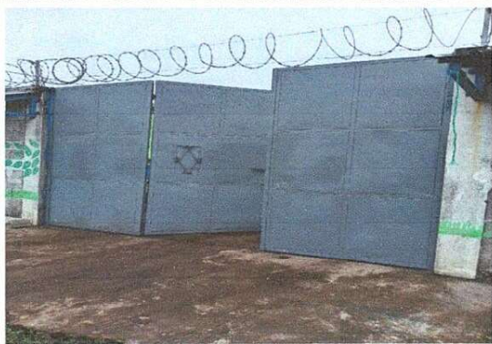
Foto 1: . Portón en proceso de mantenimiento
