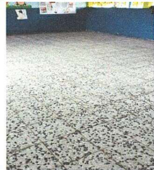
Foto 2: Salón 1 finalizado la sustitución de piso de granito
