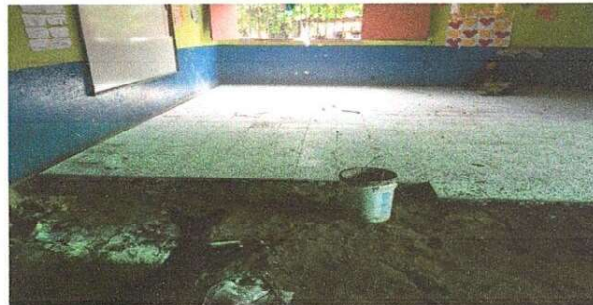
Foto 6: Sustitucion de piso de granito en proceso salon 3
