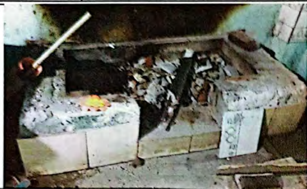
Foto 7: Desmontaje durante el procedimiento de reparación de estufa de leña en el módulo de cocina.
