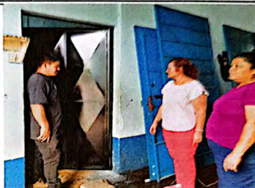
Foto 8: Proceso de reparación y ajuste en las puertas de aulas.
