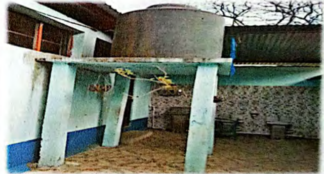
Foto 10: Sustitución de deposito de agua de 1100.00 lts
