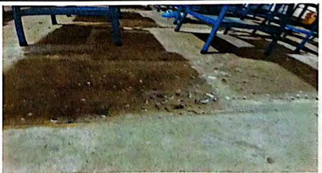
Foto 12: Sustitución de piso torta de concreto a piso ceramico antideslizante.
