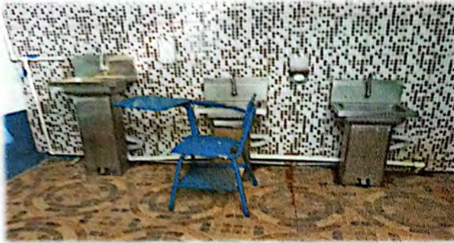
Foto 7: Reparación de tubería de agua potable en el área de lavamanos
