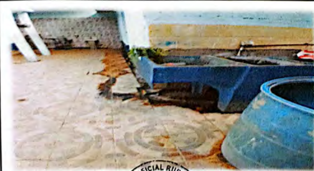
Foto 11: Reparación en el drenaje de las dorillas exteriores.
