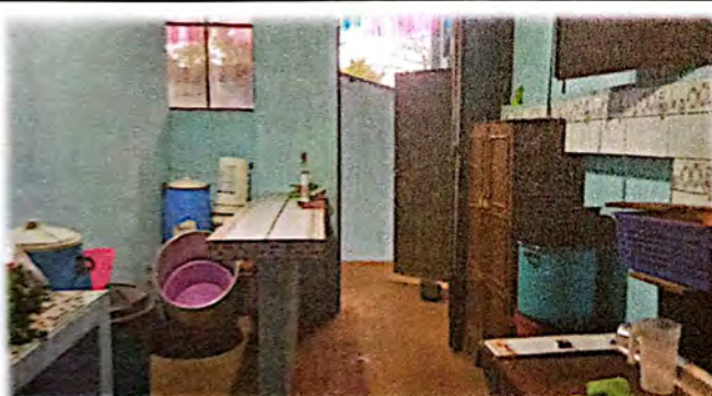
Foto 3: Sustitución de estufa rural de leña, mejoramiento en los muebles de cocina, instalación y sustitución de azulejo.
