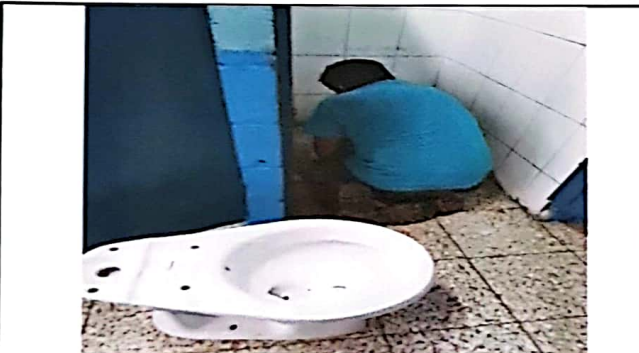
Foto 3: Instalación de nuevos inodoros en el 1r. y 2do. modulo de servicios sanitarios.
