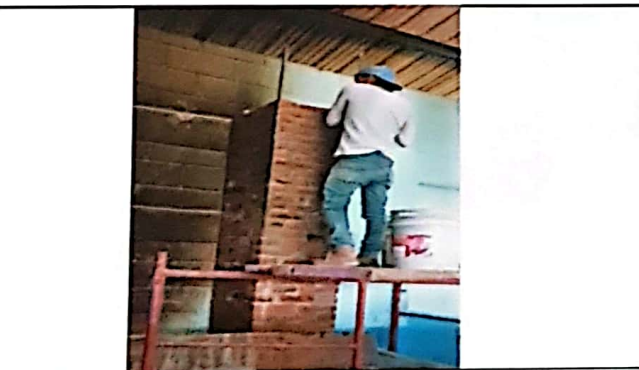
Foto 5: Proceso de ejecución de chimenea para estufa rura de leña. Con un avance del 50%.
