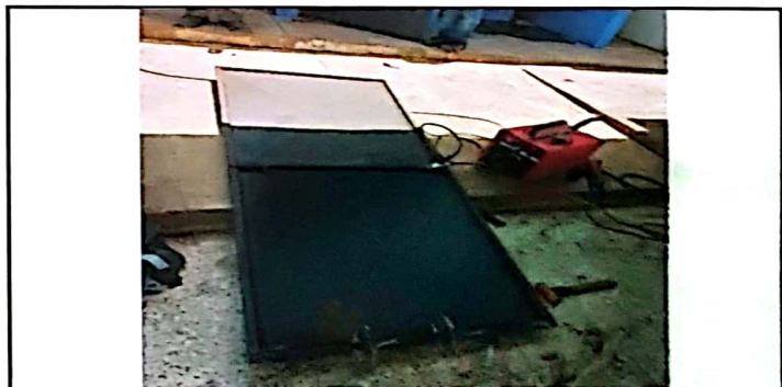
Foto 4: Proceso de reparación y mantenimiento en puertas ubicadas en el segundo modulo de servicios sanitarios.
