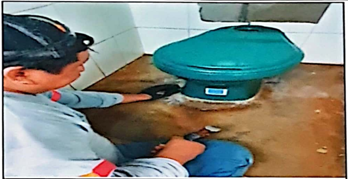
Foto 2: Desmontaje de inodoros para la instalación de nuevos inodoros en el 1r. y 2do. modulo de servicios sanitarios.
