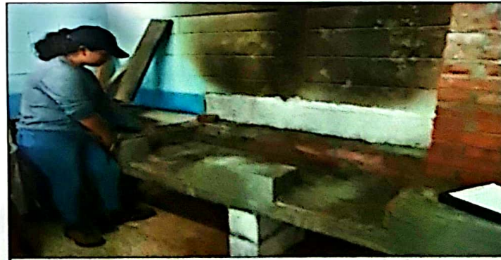
Foto 6: Proceso de ejecución de chimenea para estufa rura de leña. Con un avance del 50%.
