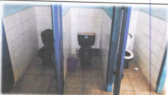
Foto 4: Mejoramiento en el 2do módulo de servicios sanitarios por medio del cambio e instalación de inodoros, incleye conexión y kit completo.
