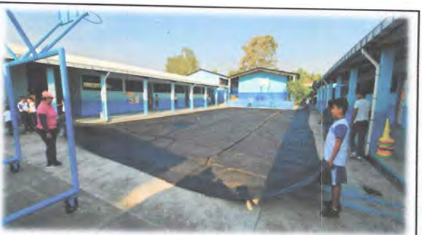
Foto 11: Reparación de zarán en el área de cancha deportiva, incluye reparación de soporte.
