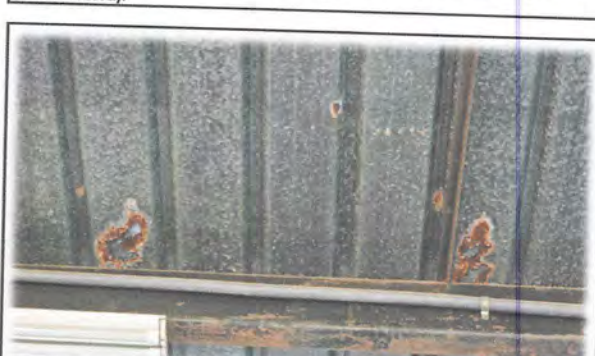
Foto 10: Es importante el cambio e instalación de lamina troquelada aluzinc calibre 26. (Incluye capote y tornillos)
