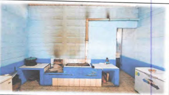
Foto 6: Cambio e Instalación de estufa de leña rural mas chimenea, y azulejo.
