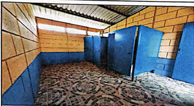
Foto 3: Suministro e instalación de piso ceramico antideslizante finalizado al 100% de su ejecución.
