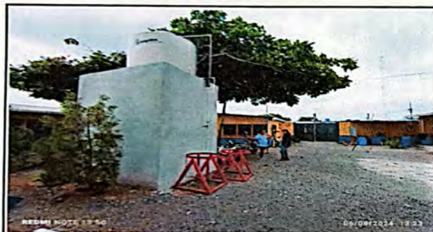
Foto 9: En el renglon 3.1 según PRA-FOR-85 se sustituyó el depósito 1,250 lts a un depósito de 2,500 lts.
