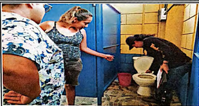
Foto 2: Evaluadora de campo supervisa que toda la instalación funcione al 100% en el modulo de servicios sanitarios.
