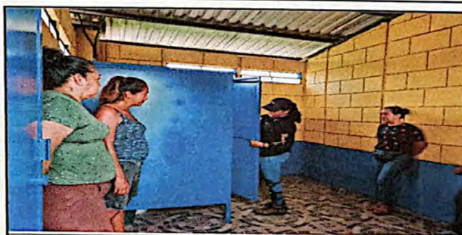
Foto 4: Herrería, mantenimiento en puertas de servicios sanitarios finalizado al 100% de su ejecución.
