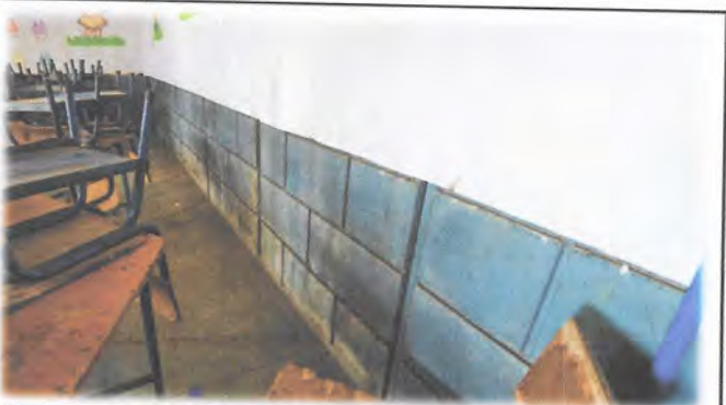
Foto 11: Reparación de repello mas cernido en muro por humedad. Incluye impermeabilizante.
