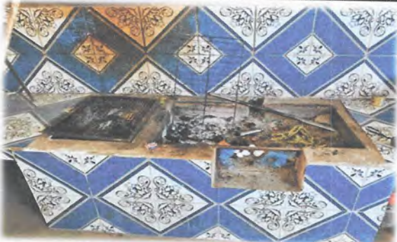
Foto 5: Mejoramiento y reparación de cocina, incluye reparación de estufa de leña rural mas chimenea y azulejo.
