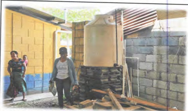
Foto 10: Cambio e instalación de deposito de agua 1250 lts, incluye accesorios, conexión de tubería y reparación de estructura base de concreto.
