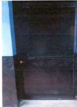
Foto 8: Mantenimiento y cambio de chapa para puerta de 2do. Grado sección A y B
