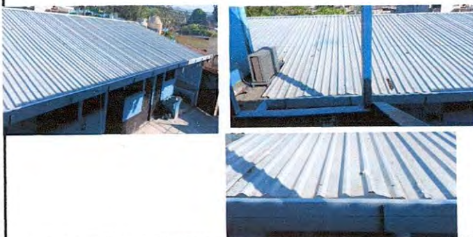
Foto 11: Sustrución de canal de metal
