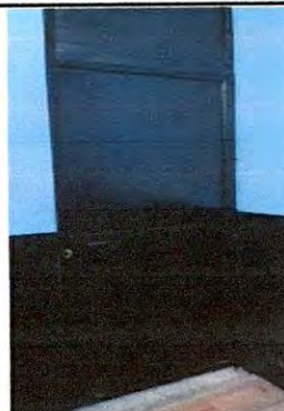
Foto 10: Sustrución de puerta, 6to. primaria sección A y B
