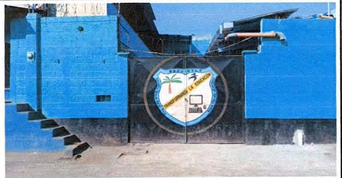
Foto 18: Pintura en muros exteriores
