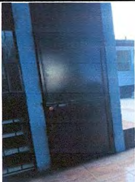
Foto 7: Sustrución de puerta para bodega de instrumentos deportivos
