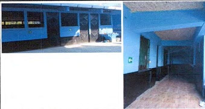
Foto 17: Pintura en muros exteriores
