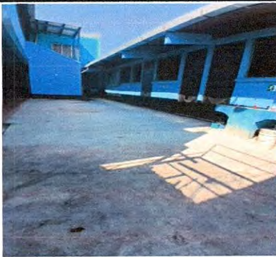
Foto 15: Reparación de piso de concreto
