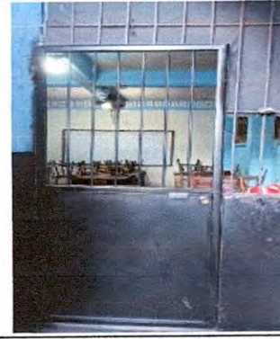
Foto 2: Sustitución de puerta, 1ro. Grado sección "C"
