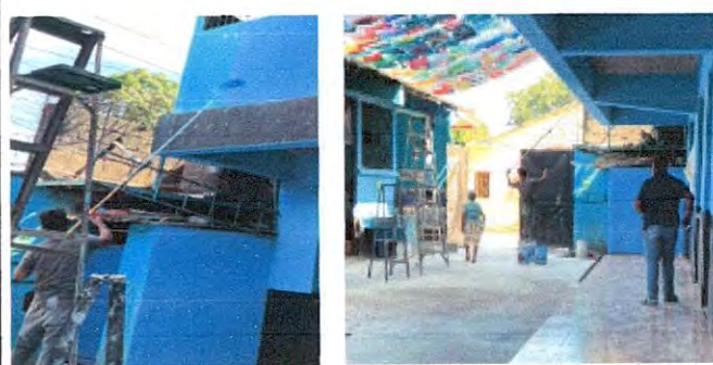
Foto 18: Pintura en muros exteriores
