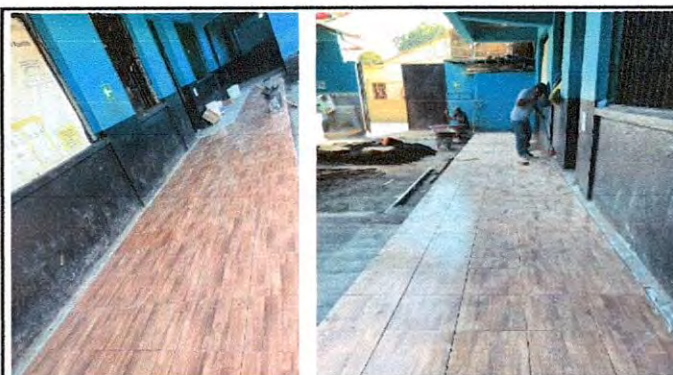
Foto 22: Sustitución de piso de torta de concreto, corredor del 1er. Nivel
