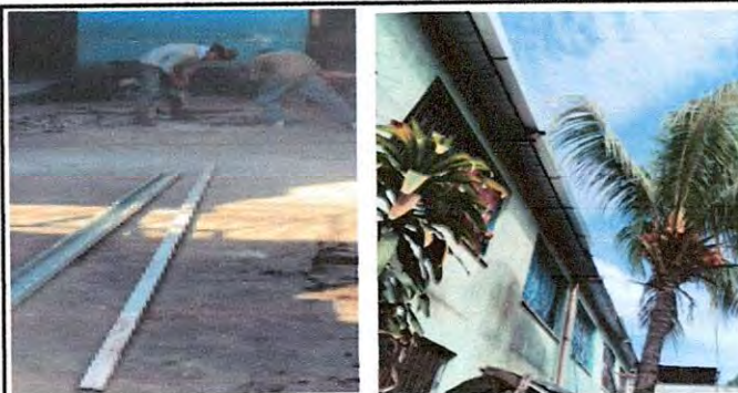
Foto 12: Sustitución de canal de metal
