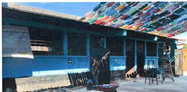
Foto 17: Pintura en muros exteriores
