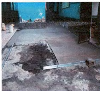
Foto 15: Reparación de piso de concreto
