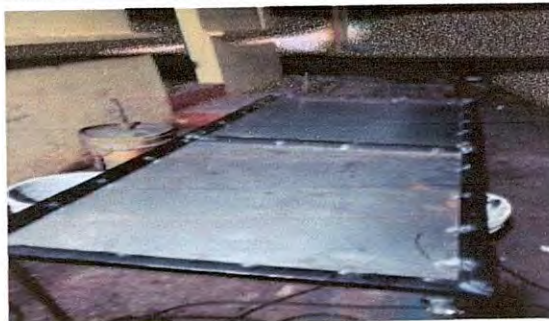
Foto 6: Sustitución de puerta para 1ro. A
