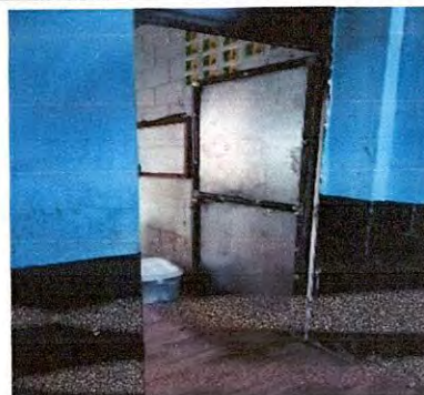
Foto 10: Sustitución de puerta, 6to. primaria sección A y B
