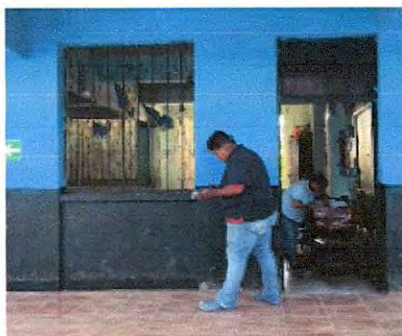
Foto 23: Mantenimiento, pinutra y cambio de chapa dirección
