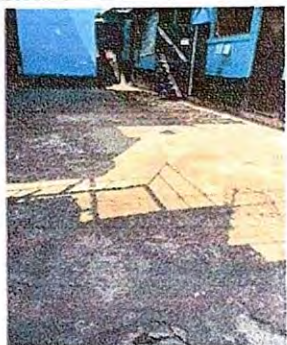
Foto 15: Reparación de piso de concreto
