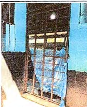
Foto1: Sustrución de puerta, 4to. Grado sección A y B.
