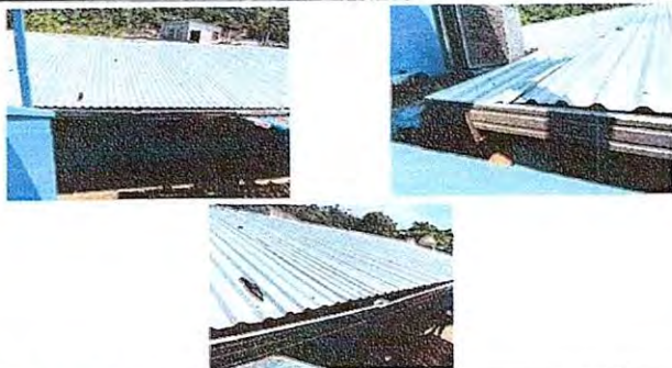
Foto 11: Sustrucción de canal de metal
