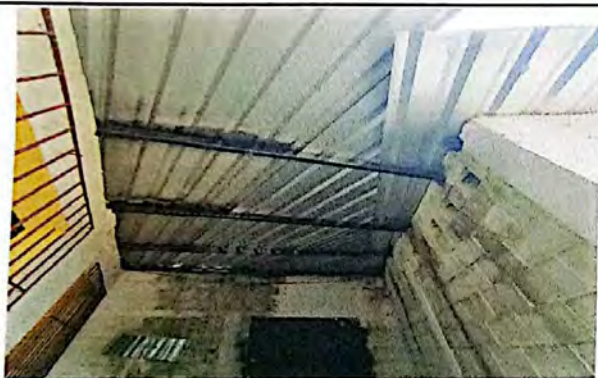
Foto 9: Vista al costado de módulo 2 de aulas, con intervención en suministro e instalación de estructura y cubierta de techo, en el ingreso peatonal.
