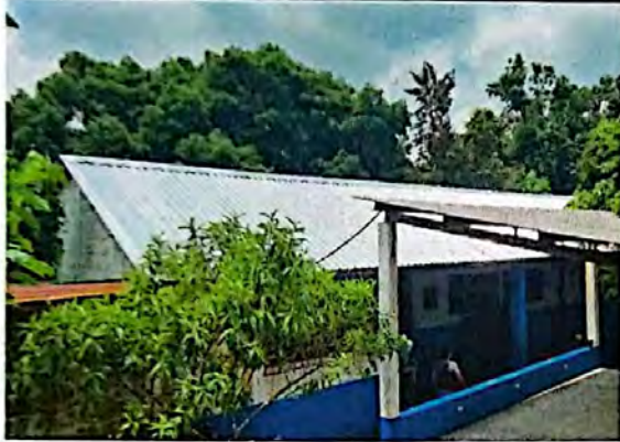
Foto 1: Vista exterior de módulo 4 de aulas, con intervención en suministro e instalación de cubierta de techo de lámina.
