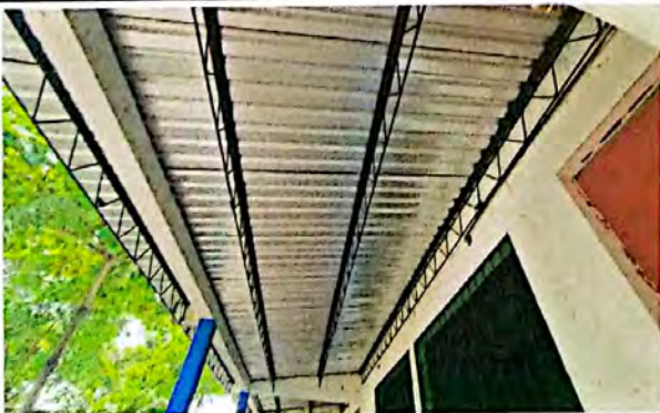
Foto 5: Vista interior del módulo 3 de aulas, con intervención en suministro e instalación de cubierta de lámina y mantenimiento a estructura de techo tipo Joist.
