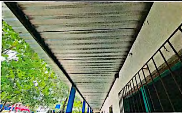
Foto 3: Vista exterior del módulo 3 de aulas, con intervención en suministro e instalación de estructura y cubierta de lámina.
