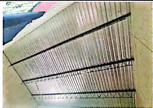
Foto 6: Vista interior del módulo 3 de aulas, con intervención en suministro e instalación de cubierta de lámina y mantenimiento a estructura de techo tipo Joist.
