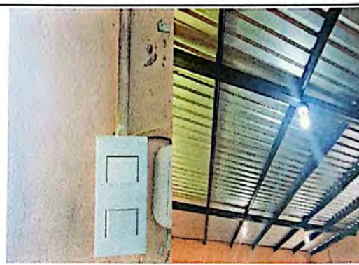
Foto 10: Vista interior módulo 3 de aulas, con intervención en mantenimiento del sistema eléctrico en cambio de apagadores, plafoneras y focos.
