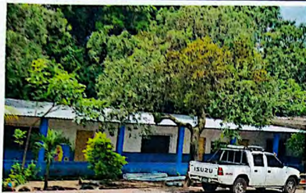
Foto 7: Vista exterior módulo 3 de aulas, con intervención en suministro e instalación de estructura y cubierta de lámina.
