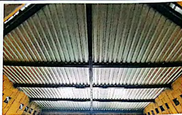
Foto 8: Vista interior módulo 2 de aulas, con intervención en suministro e instalación de estructura y cubierta de lámina.
