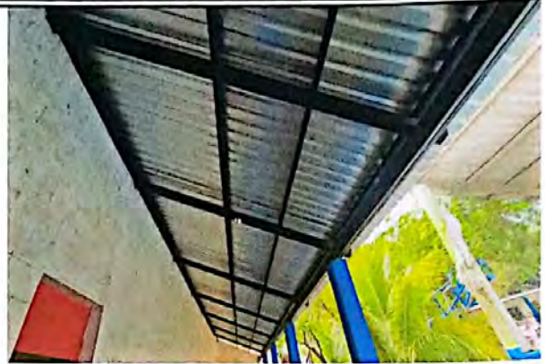
Foto 2: Vista exterior del módulo 4 de aulas en corredor, con intervención en suministro e instalación de cubierta de lámina y mantenimiento a estructura de techo.
