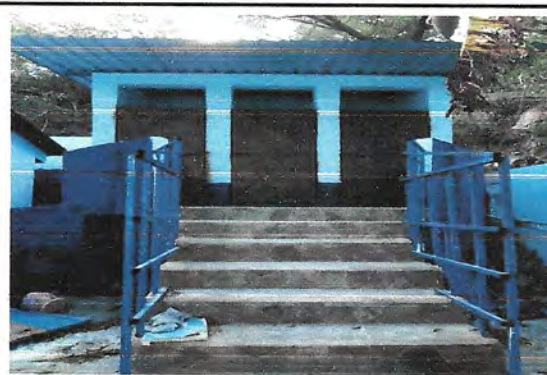
Colocación de chapa Yale y pintura a 7 puertas
