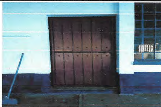
Puerta de acceso al aula #1
