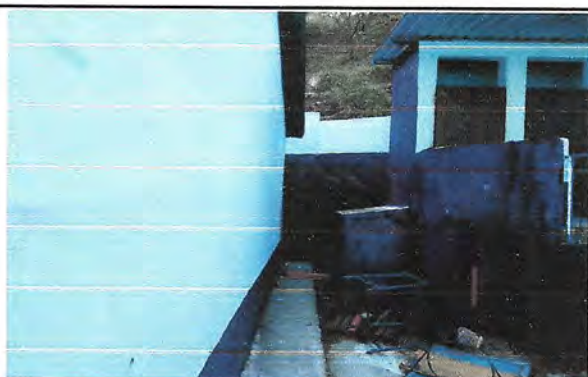
Pintura de muros exteriores e interiores
