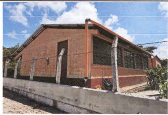
Foto 6: CERCO O MURO PERIMETRAL
