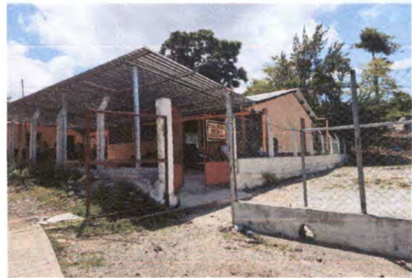
Foto 4: CUBIERTA DE LÁMINA
