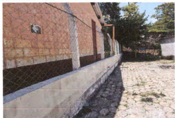
Foto 2: CERCO O MURO PERIMETRAL
