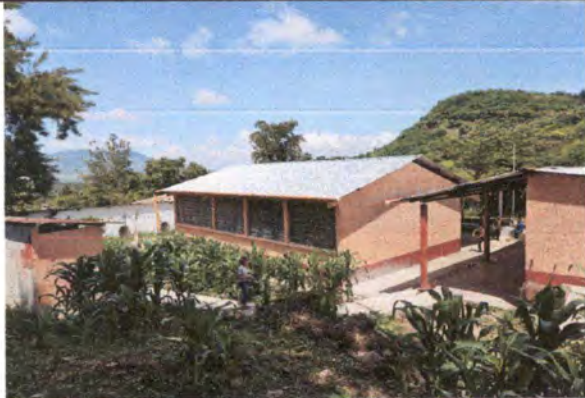
Foto 1: CUBIERTA DE LÁMINA
