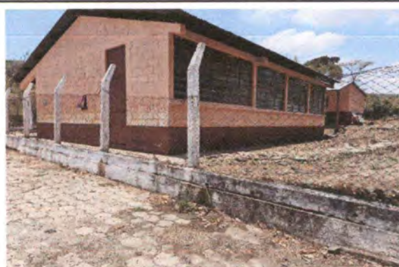
Foto 6: CERCO O MURO PERIMETRAL
