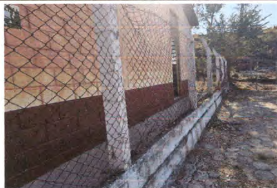
Foto 2: CERCO O MURO PERIMETRAL
