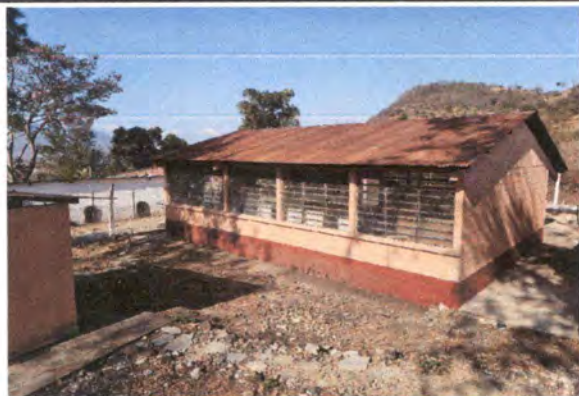
Foto 1: CUBIERTA DE LÁMINA
