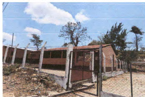
Foto 4: CUBIERTA DE LÁMINA
