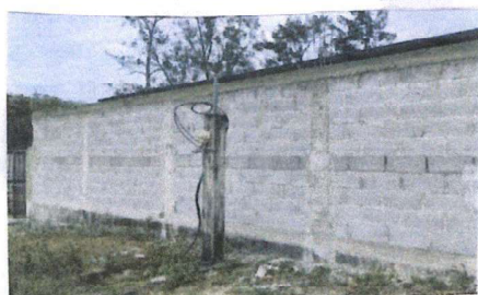
Foto 3: sustitución y mantenimiento de muro perimetral
