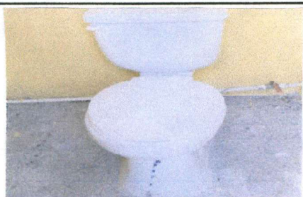
Foto 5: Sustitución de sanitarios
