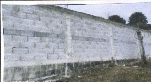
Foto 1: sustitución y mantenimiento de muro perimetral
