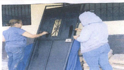
Foto 4: Pintura de puertas
