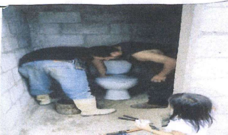
Foto 5: Sustitución de sanitarios
