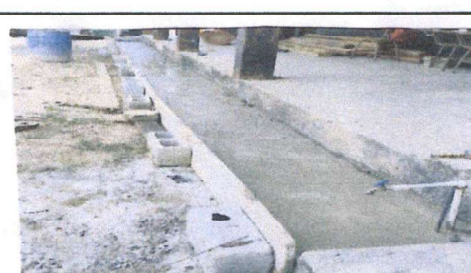
Foto 6: Mantenimiento de banquetas de concreto
