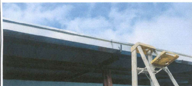
Foto 3: Canales y Bajadas de Agua Pluvial
