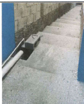
Foto 5: Losa de Patio
