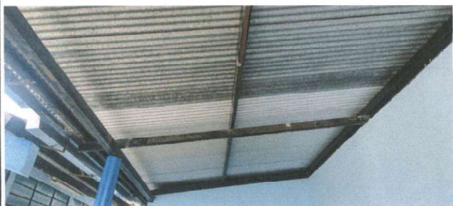
Foto 1: Cubierta de Lámina
