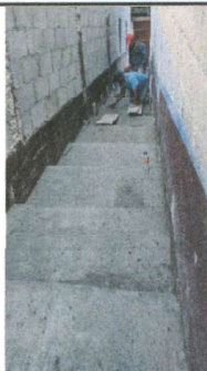
Foto 5: Losa de Patio
