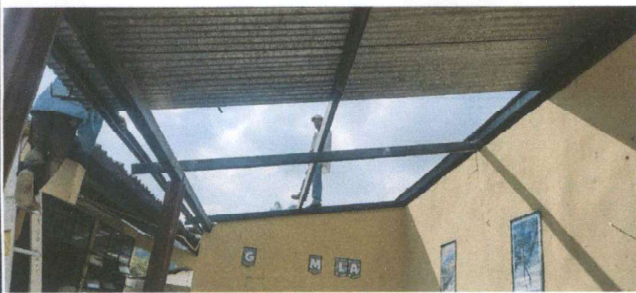
Foto 1: Cubierta de Lámina
