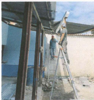
Foto 3: Canales y Bajadas de Agua Pluvial
