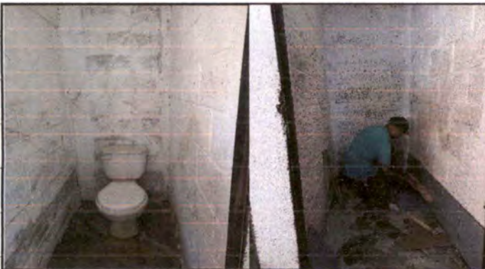
Foto 3: Situación durante la sustitución de inodoro, azulejo y piso.
