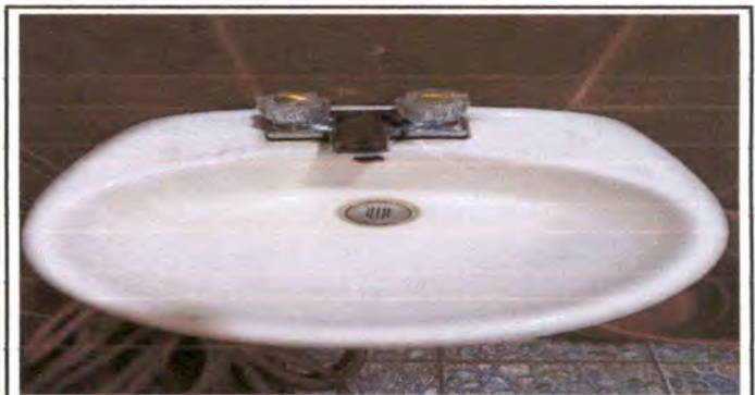
Foto 6: Situación durante la sustitución de chorro.
