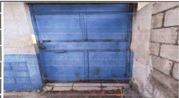
Foto 9. Situación de puerta previ a sustitución.
