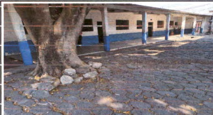
Foto 2. Concreto de patio escolar previo a remozamiento
