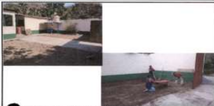
Foto 1: LOSA DE PATIO. NIVELACIÓN DE TERRENO
