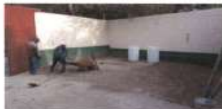
Foto 2: LOSA DE PATIO. NIVELACIÓN DE TERRENO
