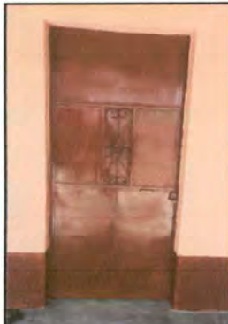
Foto1: Estado final de puertas
