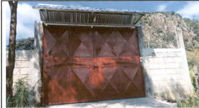
Foto 2: Estado final de portón principal con techo de metal
