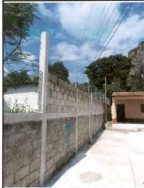
Foto 7: Estado final del muro perimetral de block con tubo hg y malla galvanizada
