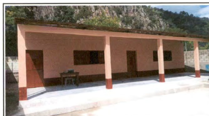
Foto 16: Estado final de repello en muro y pintura.
