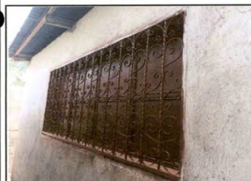
Foto 17: Estado final de refuerzo en balcones de aula.
