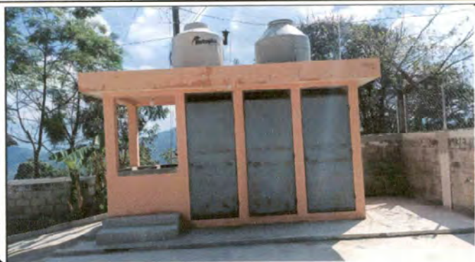
Foto13: Estado final depósito de agua 110 lt
