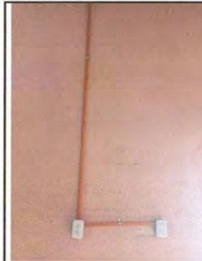
Foto 10: Estado final de los interruptores y tomacorriente dobles
