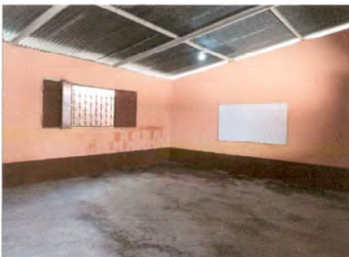
Foto 5: Estado final de piso de torta de concreto (aulas)
