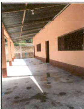
Foto 4: Estado final de piso de torta de concreto (corredor)
