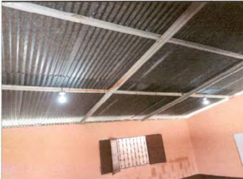
Foto 9: Estado final de focos ahorradores y plafoneras
