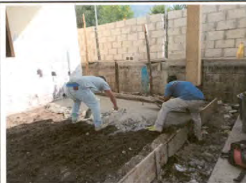
Foto 8: Proceso No. 2: Sustitución de piso de torta de concreto en corredor.
