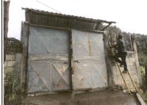
Foto 2: Proceso No. 1: Mantenimiento a portón de metal.
