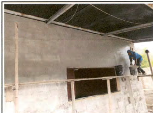
Foto 22: Proceso de repello en muro (pared frontal)
