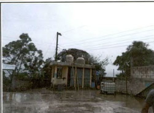
Foto 19: Sustrucción de depósito de agua 1100 lt.
