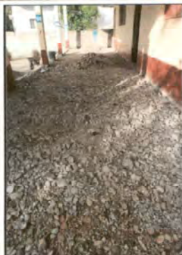
Foto 7: Proceso 1: Sustitución de piso de torta de concreto en corredor.
