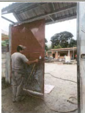
Foto 3: Proceso No. 2: Mantenimiento a portón de metal.
