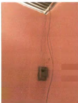
Foto 17: Sustitución de flipones.
