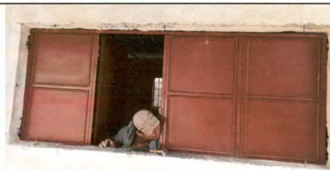
Foto 5: Proceso No. 2: Sustitución de estructura de metal de ventana.
