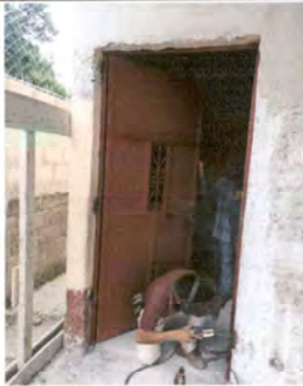
Foto 1: Proceso de instalación de puertas.
