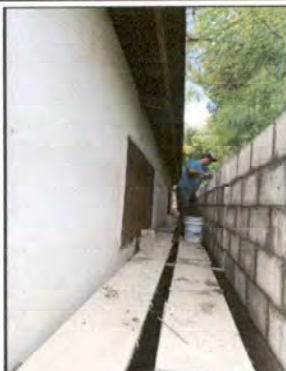
Foto 13. Proceso No. 2: Reparación de muro perimetral de block con tubo hg y malla galvanizada.
