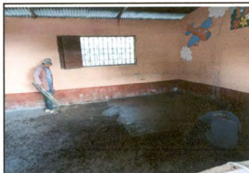
Foto 9: Proceso No. 3: Sustitución de piso de torta de concreto en aulas.
