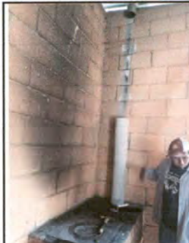
Foto 20: Proceso de sustitución de chimenea de concreto.
