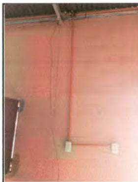
Foto 16: Proceso de sustitución de interruptores y tomacorrientes dobles.
