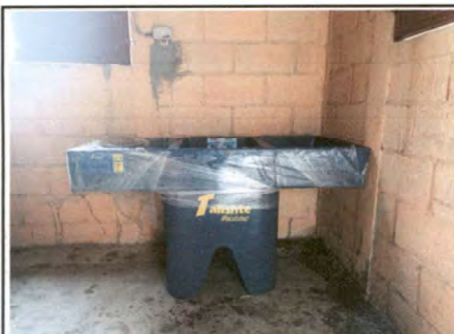
Foto 21: Proceso de Sustrucción de pila plástica con dos lavaderos en cocina escolar.
