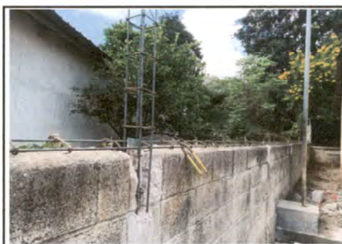
Foto 12: Proceso No. 1: Reparación de muro perimetral de block con tubo hg y malla galvanizada.
