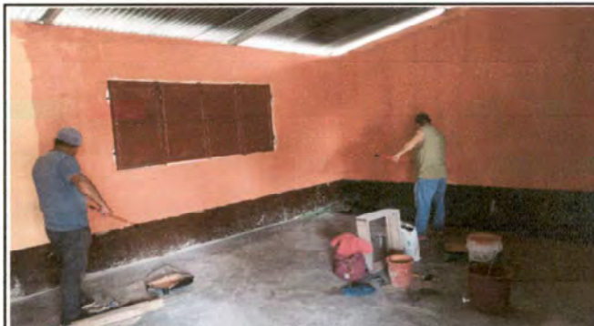
Foto 10: Proceso No. 1: Aplicación de pintura en muros interiores (aulas)
