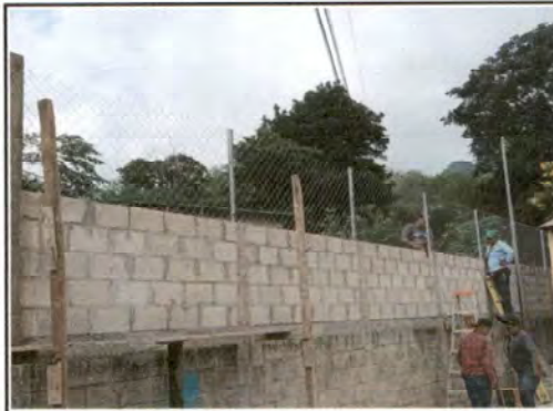
Foto 14: Proceso No. 3: Reparación de muro perimetral de block con tubo hg y malla galvanizada.
