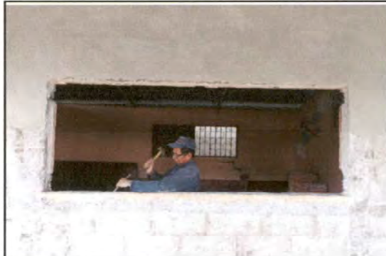
Foto 4: Proceso No. 1: Sustitución de estructura de metal de ventana
