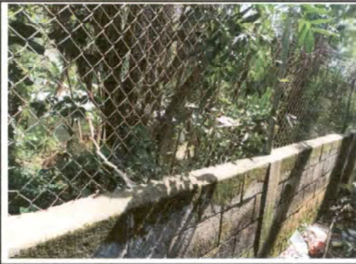
Foto 8: Estado inicial de muro perimetral exterior
