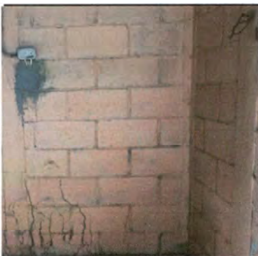
Foto 15: Espacio para colocar la pila.
