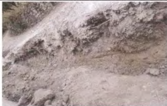
Foto 4: Zanjo ya terminado
