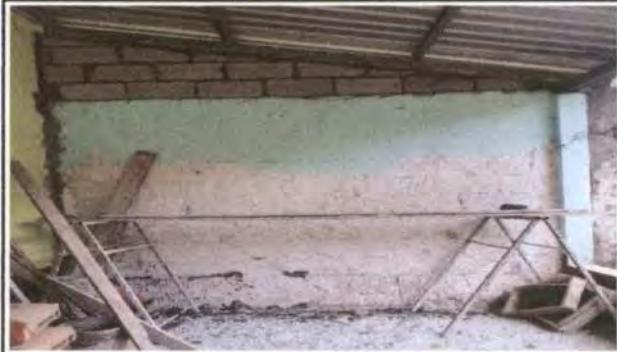
Foto 2: Proceso de reparación de pared del corredor.
