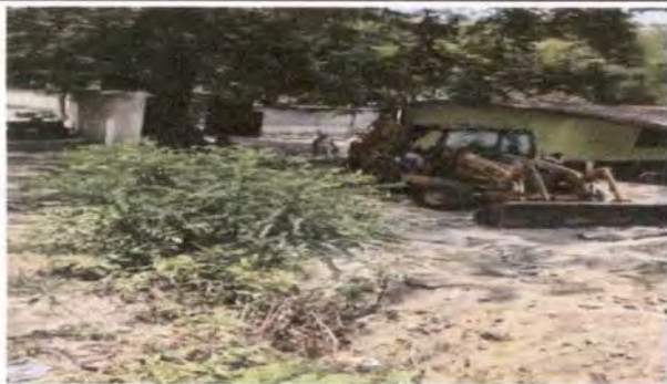
Foto 3: Comienzo del zanjo con máquina escavadora
