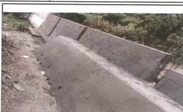
Foto 2: Comienzo ya de muro perimetral
