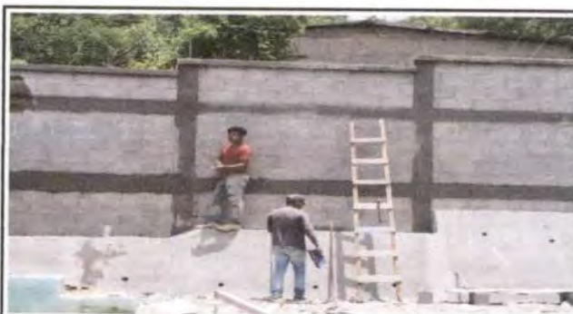
Foto 6: Tallado del muro perimetral.
