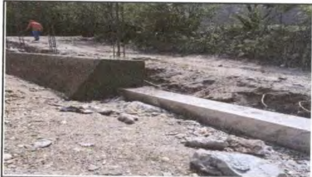
Foto 4: Muro de contención ya fundido, lado de enfrente.
