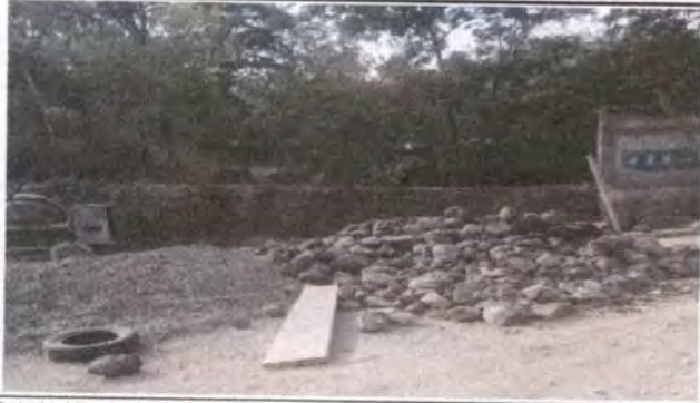
Foto1: Momento del cimiento.
