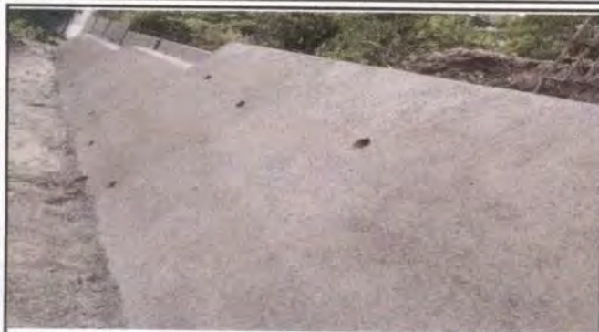
Foto1: Muro de contención ya terminado
