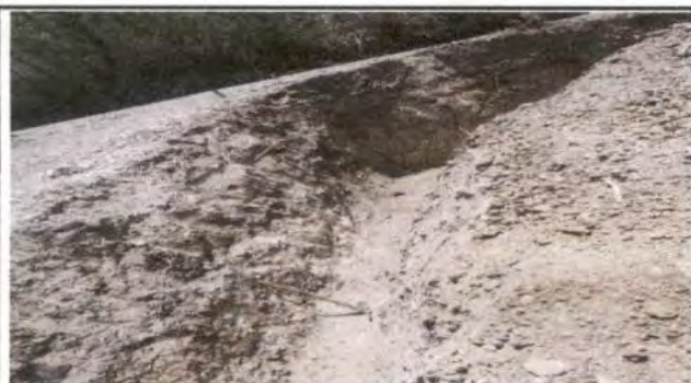
Foto 5: Zanjo, la lado de la calle
