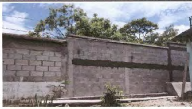
Foto 2: Tallado de muro perimetral, lado de enfrente.
