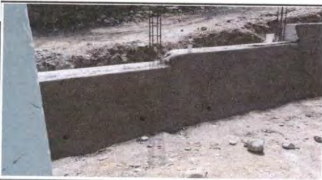
Foto 5: Muro de contención fundido en su totalidad
