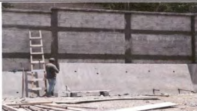
Foto1: Terminación de tallado de muro perimetral
