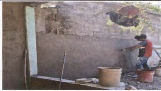
Foto 3: Repellado de pared, parte del muro perimetral.
