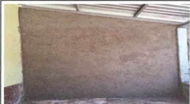
Foto 4: Terminado repello de pared del corredor.
