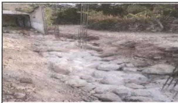
Foto 6: Fundición de cimiento, con piedra y mezcla con cemento, arena y pedrín.
