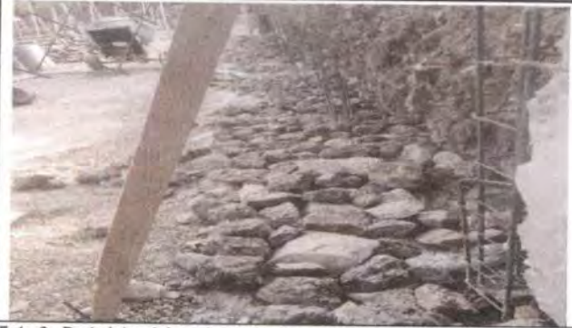
Foto 2: Parte lateral derecha ya fundida con cemento de piedra
