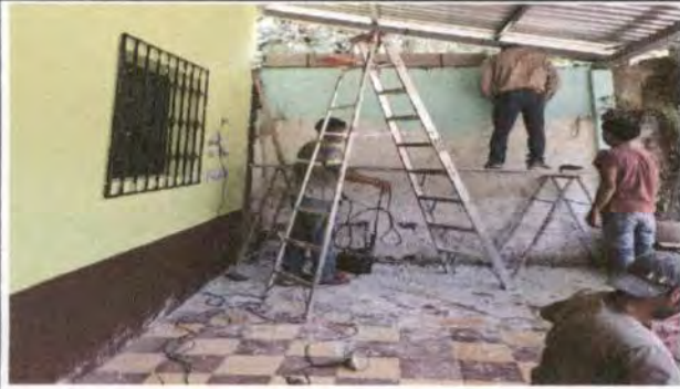
Foto1: Reforzando pared del fondo, corredor.
