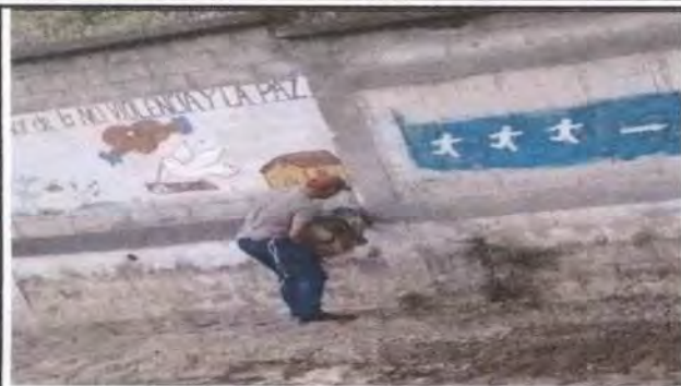
Foto1: Derribando muro en mal estado
